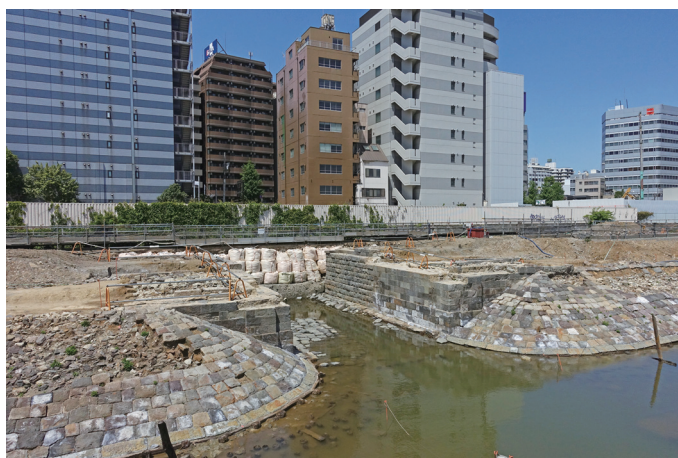
図1 高輪築堤 第7橋梁橋台部 (画像提供：港区立郷土歴史館)
