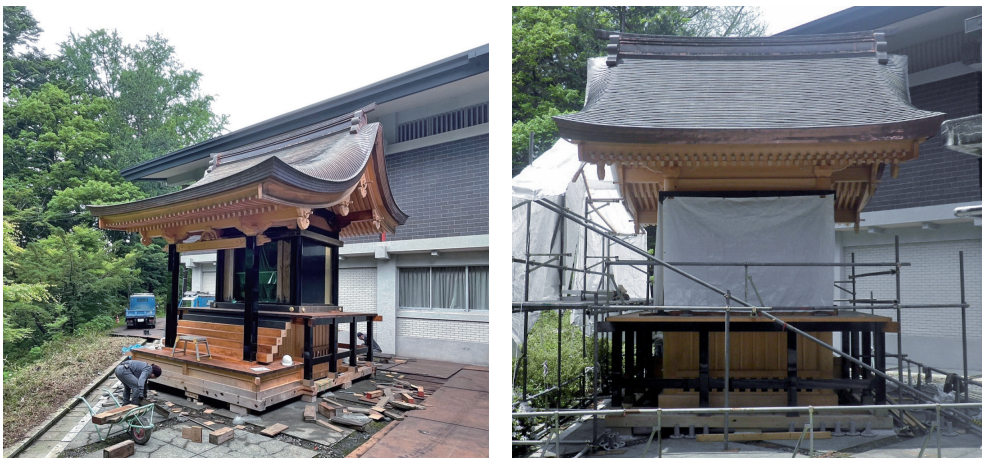
図1 湿度制御した温風処理を実施した一間社 左：正面側（2022年7月引き家後）右：背面（2022年4月）
