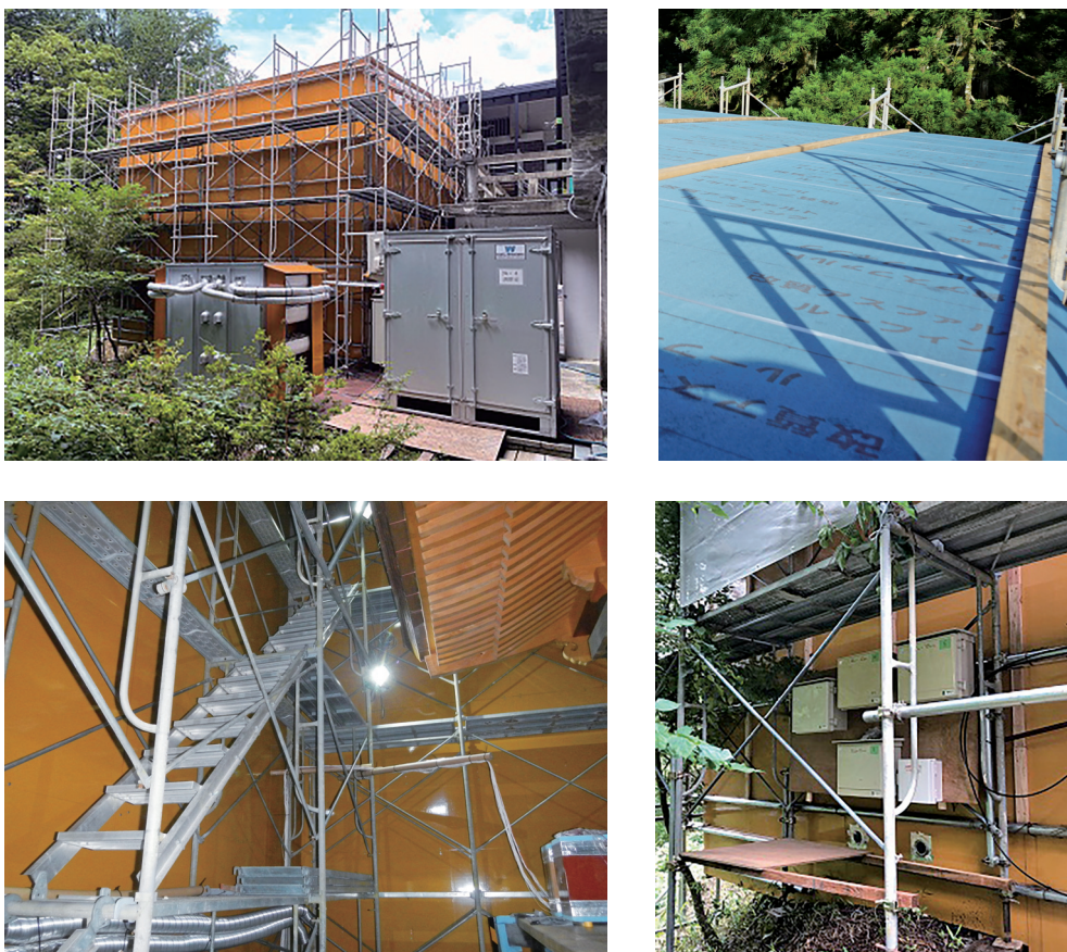
図2 覆い屋の状況
