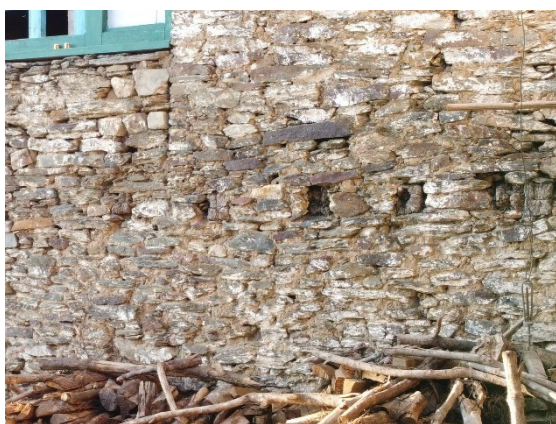
写真 20 正面の根太痕跡
