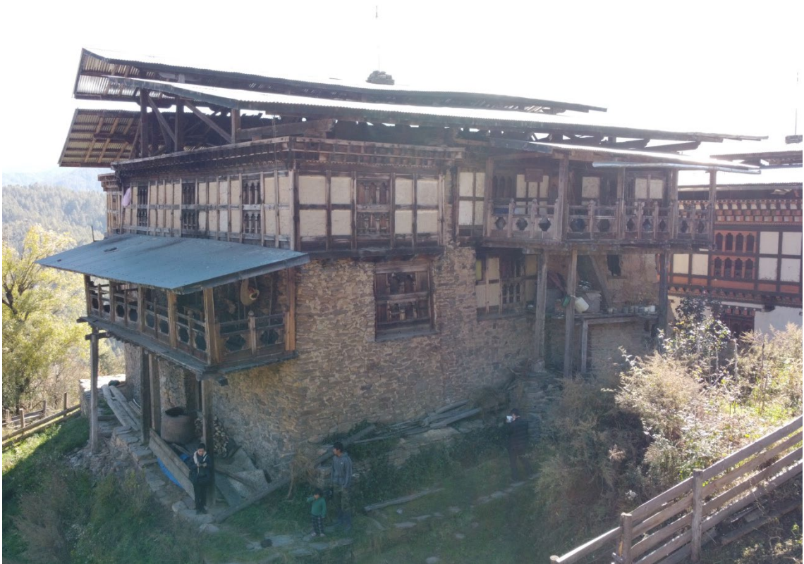
3-5. ドルジ.ラム邸 背面（西面及び北面）
