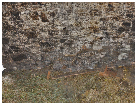
写真 31 2階西壁の積直し痕跡
