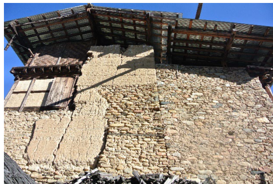
写真13 版築と石積みの混用がみられる外壁
