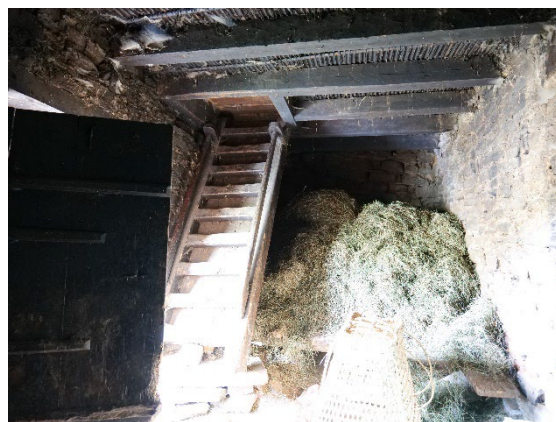
写真 33 1階東室 北から
