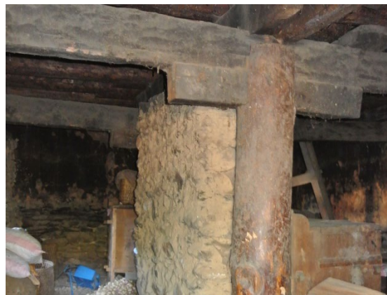
写真 23 1 階物置の石積壁と木部
