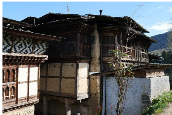
写真3 集落南西端の民家の傾斜した版築壁と木部
