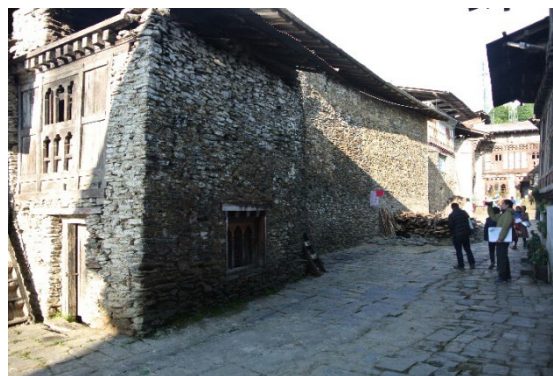
写真7 道路側に開口部がほぼない3棟続きの民家
