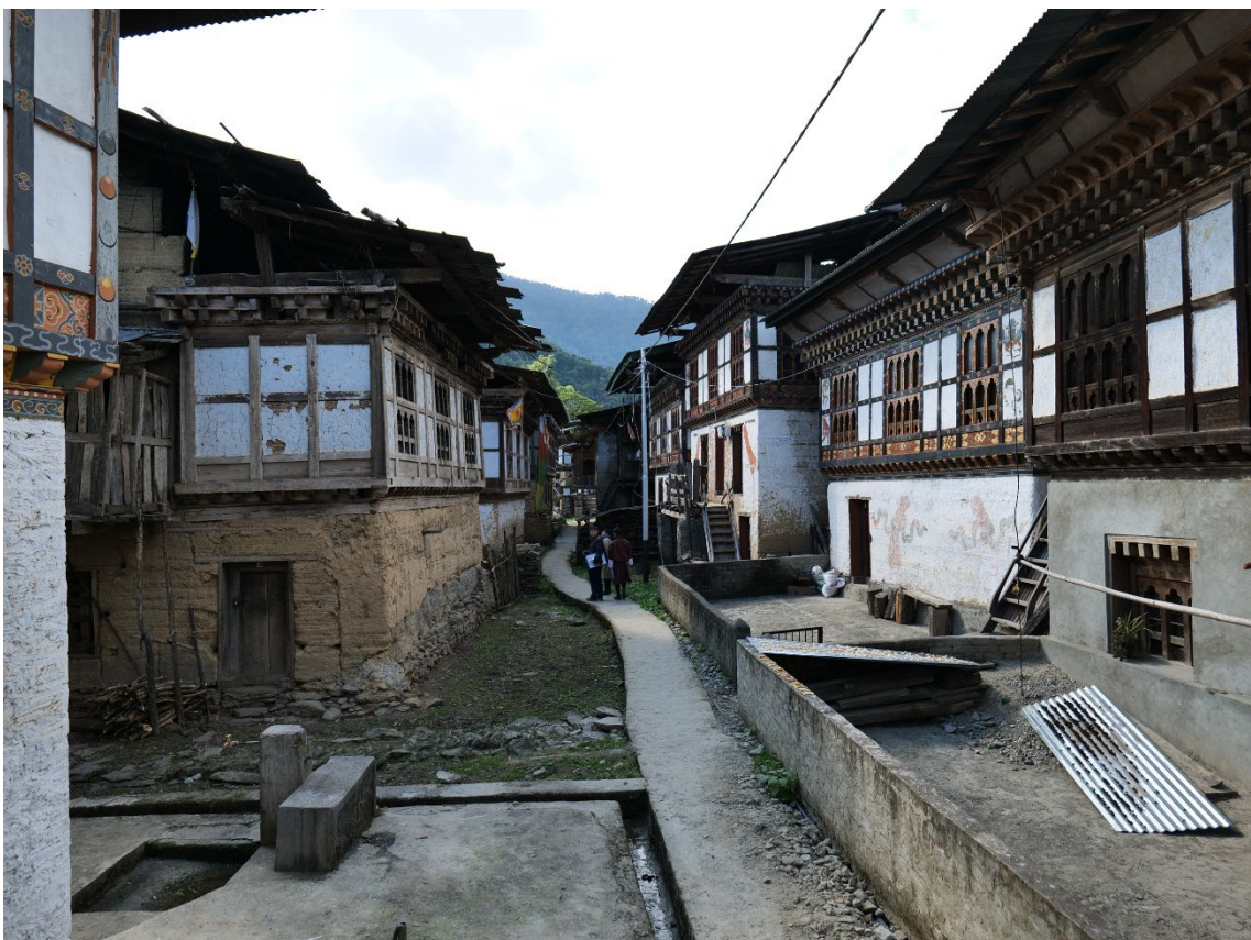
2-4. コープ 集落北道沿いの家並み 東から
