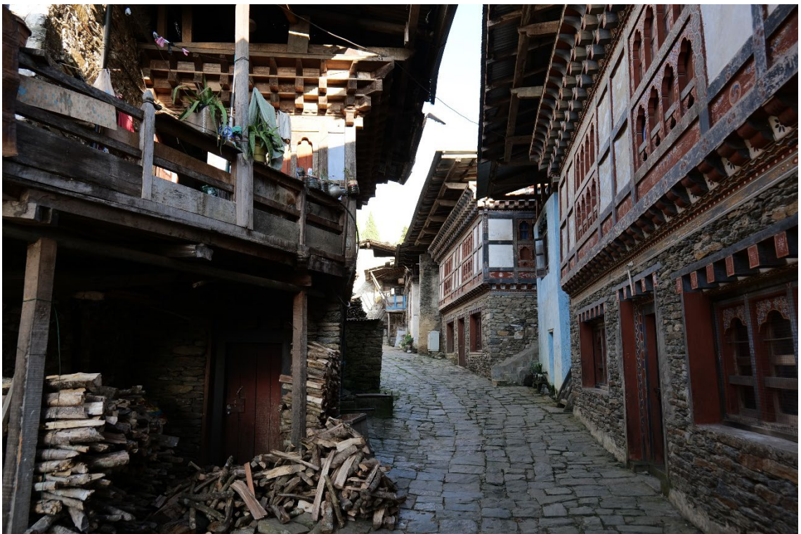
2-3. トゥロン 集落上手の道路沿いの家並み 西から
