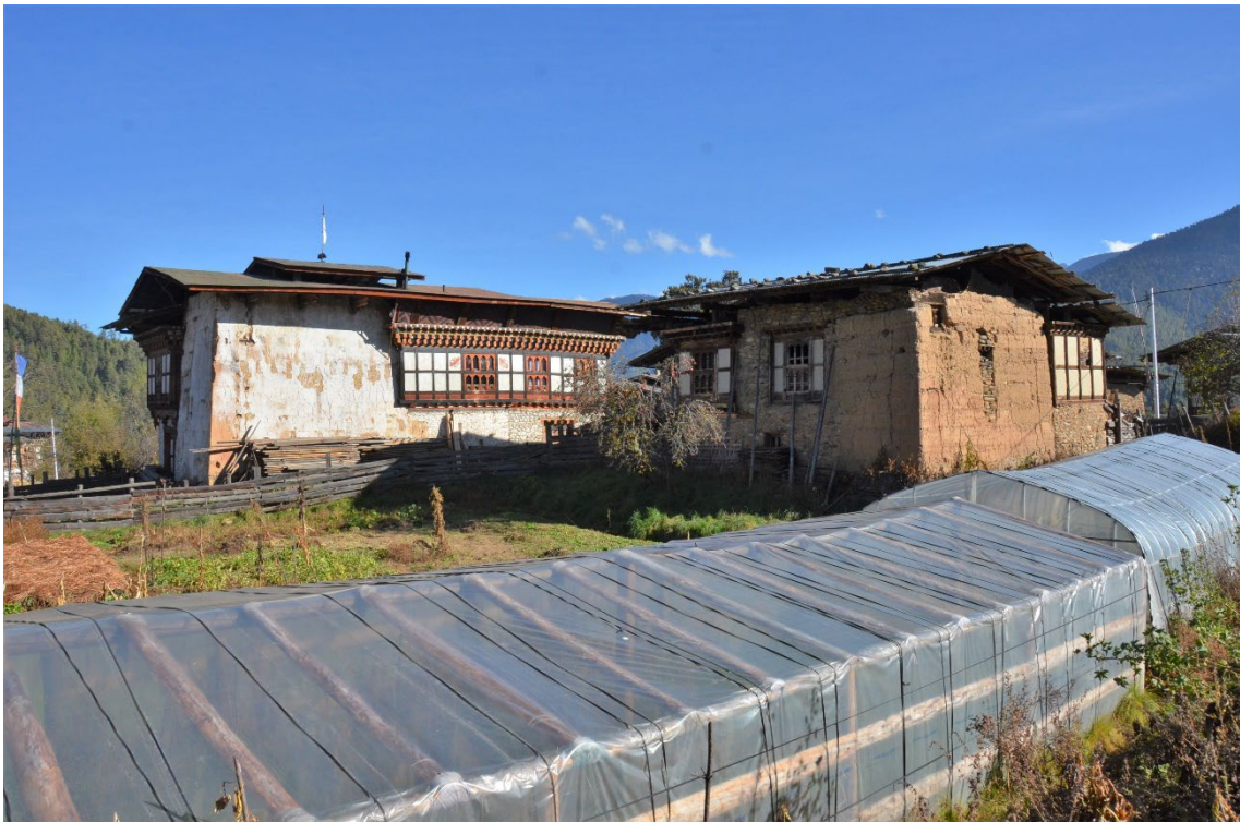
2-6. ゲツァ 石造の増築部をもつ版築造民家（詳細調査候補）
