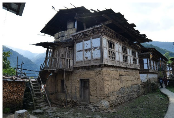
写真9 道に面してラブセルをまわす版築造民家
