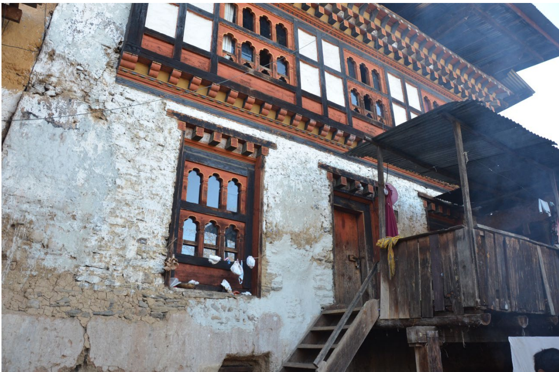
3-3. ラム.テンジン邸（ドゥンカル） 正面（東面）
