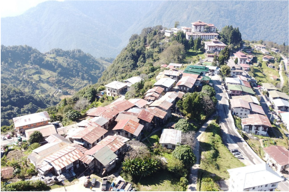
2-3. トゥロン 集落全景（最奥の建物がシェムガン.ゾン） 北東から
