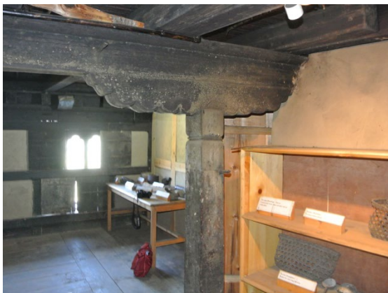
写真 26 3階広間にある繰形をもつ肘木
