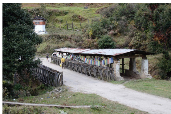
写真5 集落入口に架かる屋根付き橋
