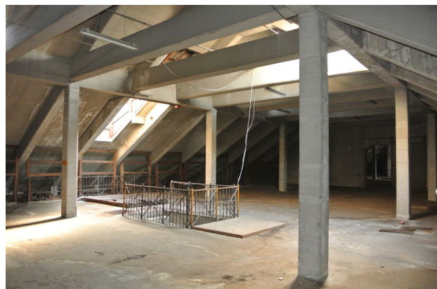
旧広島陸軍被服支廠 1913年建築の鉄筋コンクリート構造(木骨煉瓦造の木部を鉄筋コンクリートに置き換えて不燃化を図ったとみられる)
