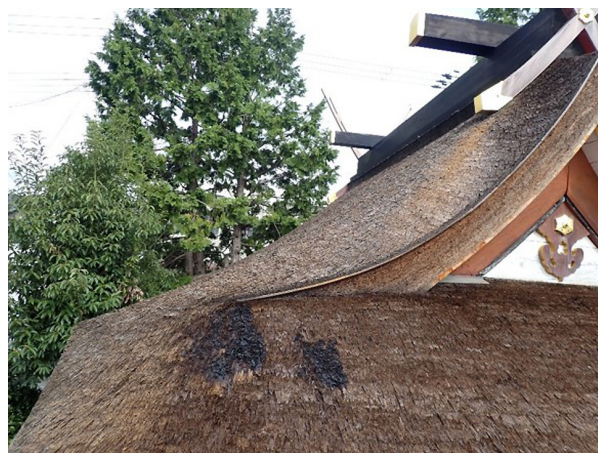
文化財建造物の防火対策に関する調査 飛び火を受けた檜皮の事例(崇道天皇社)
