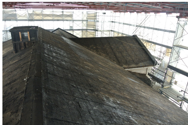
遺愛学院本館 1911年建築当初のアスファルトルーフィング葺(現在は鉄板葺)とされており今回の保存修理工事でも現状維持の予定)
