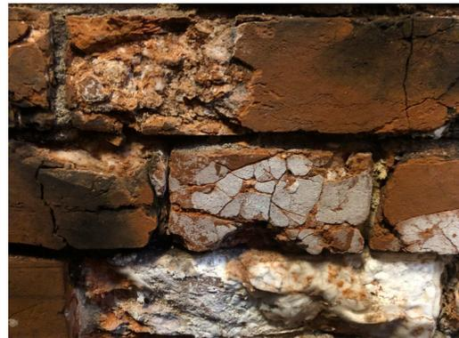
図2 内部の金属の腐食に伴う煉瓦の亀甲状の割れ
