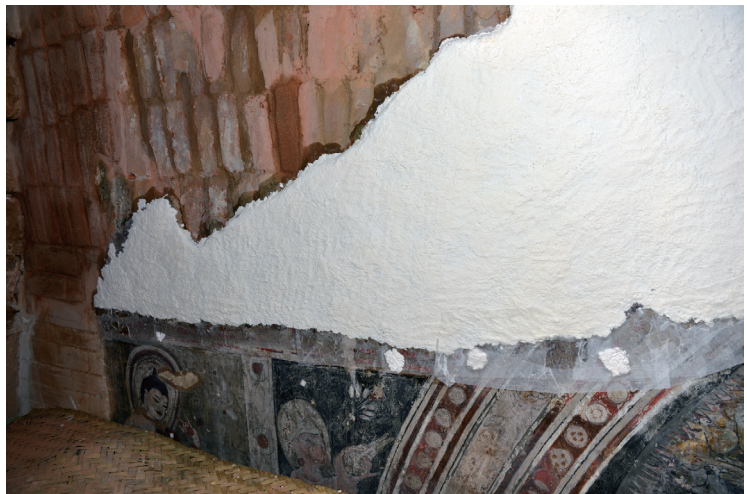
無機修復材料を用いた漆喰及び彩色層の補強
