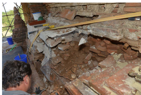
震災による被災箇所 の処置風景
