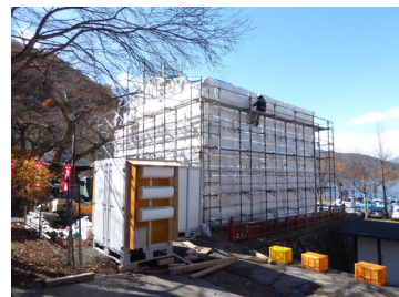
日光山内の社寺での加湿温風殺虫処理の様子
