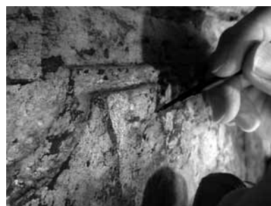
膠漆による剥落止め
