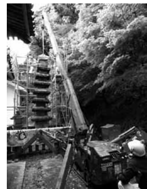
宝積寺九重石塔の解体作業
