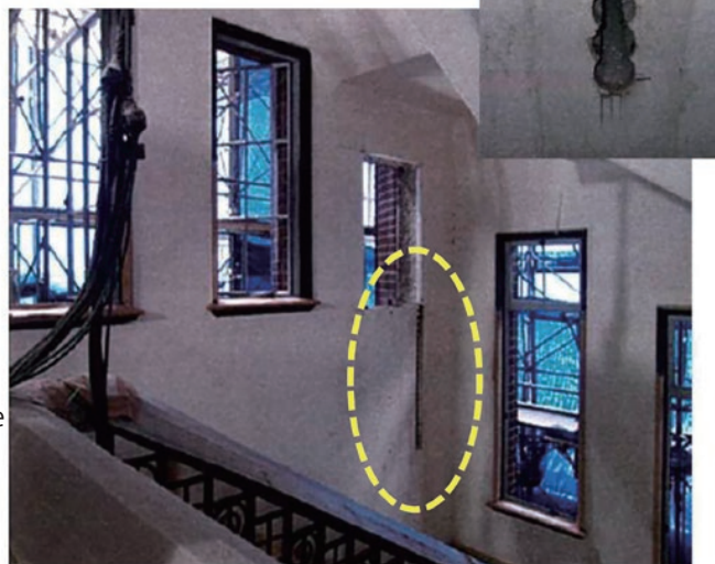
figure 6 anti-seismic slits (reprinted from 『東京大学大講堂（安田講堂）改修工事報告書』（東京大学 平成28年（2016）3月）, images were edited)
