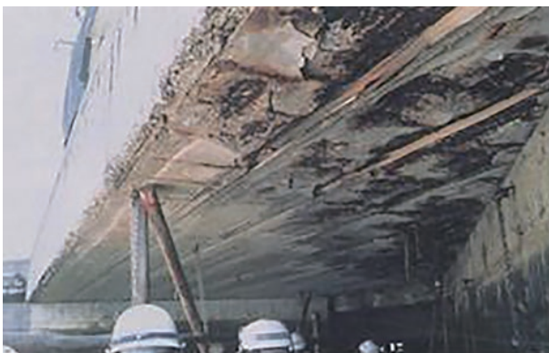
photo 2 Example of deterioration (left 3 : extracted from (公社) 日本コンクリート工学会、コンクリートのひび割れ調査、補修・補強指針 2009) right : building no. 65 on Gunkan-jima : photo taken with special permission by Nagasaki City)
