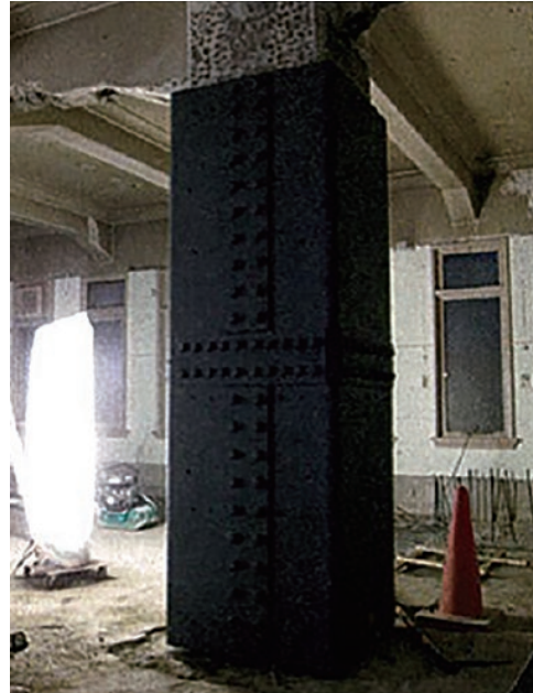
photo 25 Reinforcement of first floor columns by wrapping with steel plates reprinted from 『東京大学大講堂（安田講堂）改修工事報告書』（東京大学 平成28年（2016）3月）
