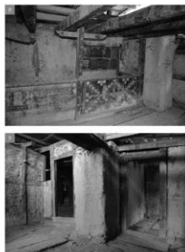
■ 2階初層 ■ 3階小梁梁部比較と板築壁
