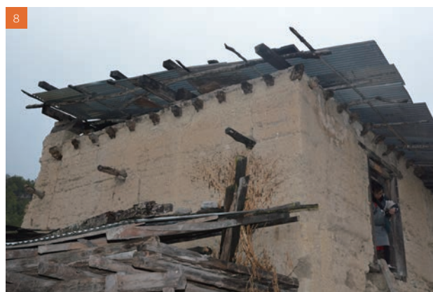
8 2階南正面から西側にかけて残る出窓の持送り
