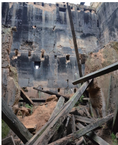
崩落した内部の版築壁中央部分 西からみる
