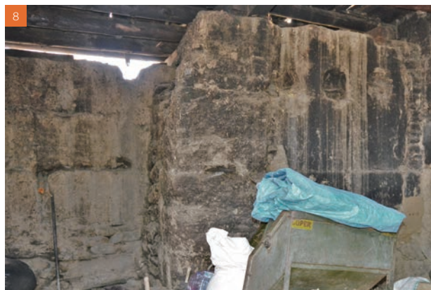
8 前身建物南西隅部の版築壁切断面
