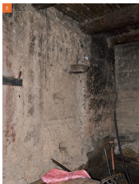
8 1階付属部の南壁に残る間仕切壁の取付き痕跡
