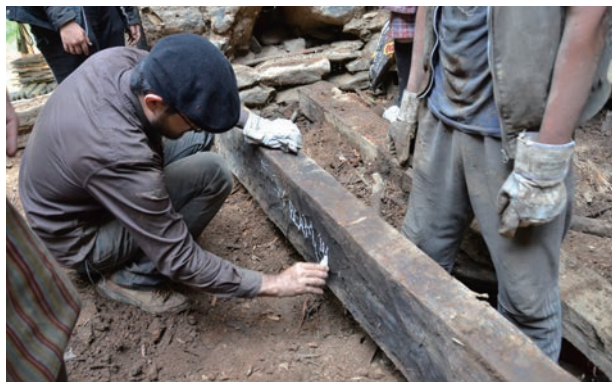
左上：建物前面にある回収木材の保管場所 右上：崩落した木材にチョークで仮番号を振る 左：崩落した木材の回収
