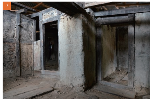
8 2階穀櫃 9 3階の木製間仕切壁と版築壁
