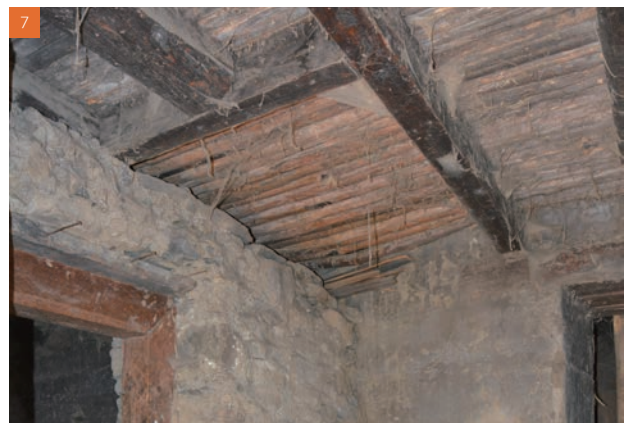
7 2階床の開口痕（下より見上げる）
