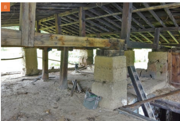
8 小屋裏（版築構造体は当初建物の四隅を示している）
