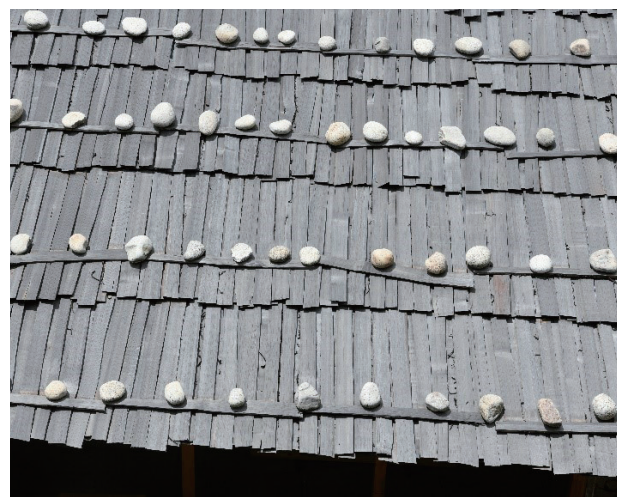
現代工法と伝統工法をあわせた板葺屋根の例 (パロ近郊の保存再生民家)
