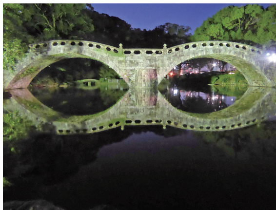
図5 諫早公園内に移築された重要文化財・眼鏡橋
