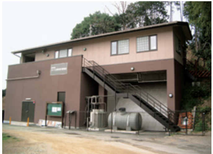
Fig. 2-7 仮設覆屋（南東から）
