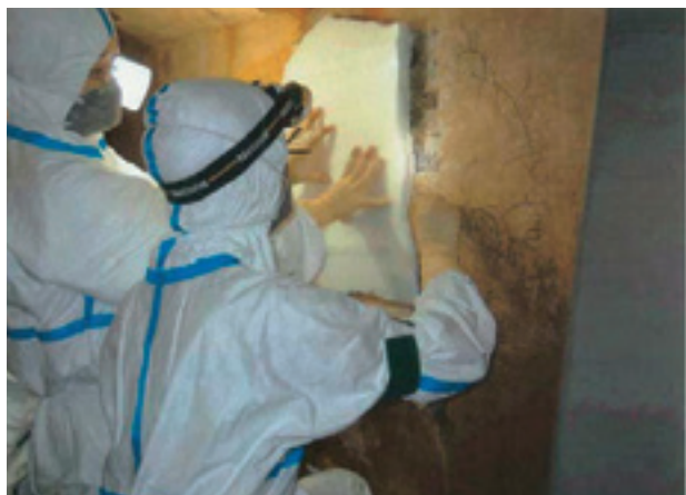
Fig. 3-9 接着部分を切り離し、壁面を取り外した。
