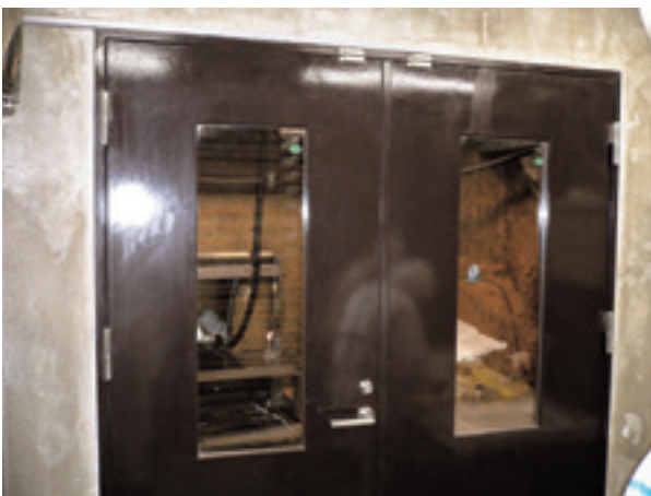
Fig. 2-9 仮設覆屋 前室扉
