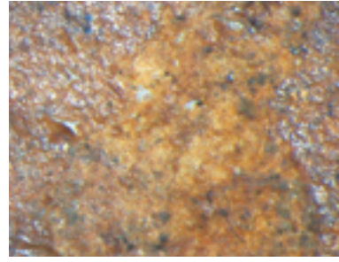
Fig. 4-30 クリーニング処置後（バイオフィームの除去と同時に、剥落止めを行った。）
