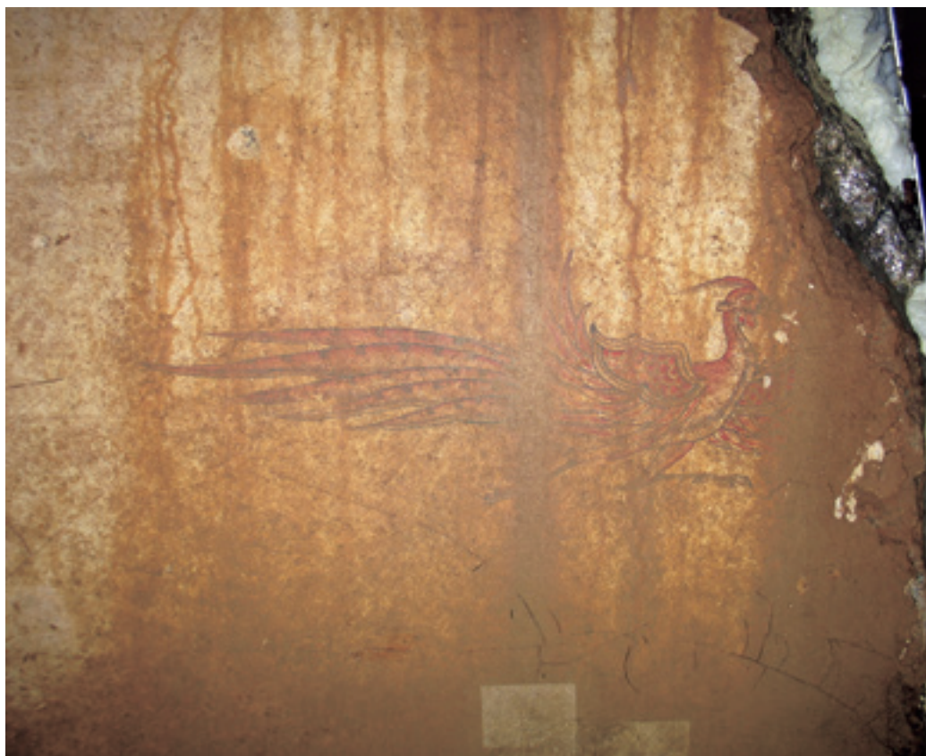
Fig. 2-21 南壁の汚れ(朱雀像周辺)
