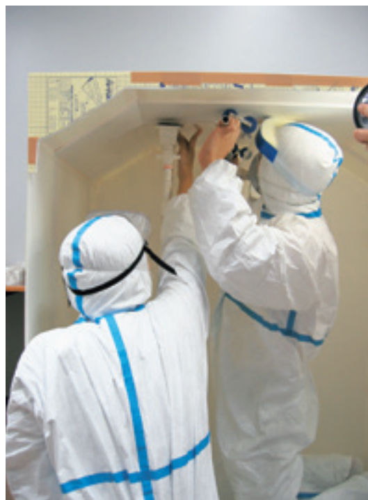
Fig. 3-61 天井の漆喰の取り外し方法の検討
