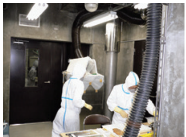
Fig. 2-10 仮設覆屋 前室
