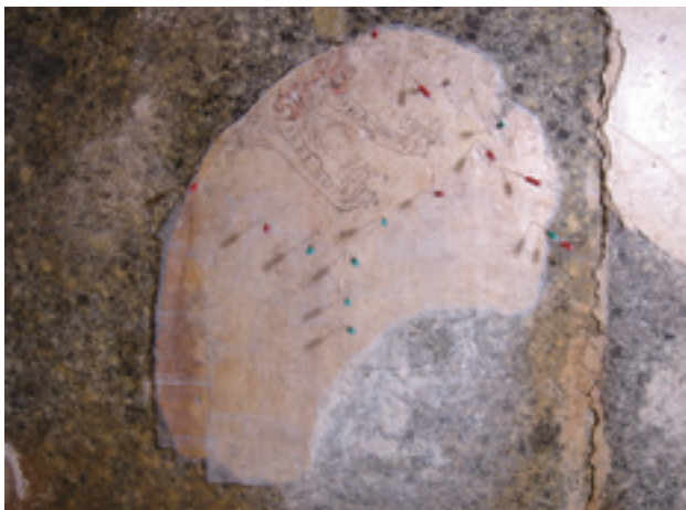
Fig. 3-4 リーマー (歯科用具) により漆喰の硬さと厚さを確認した。
