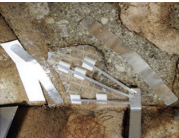
Fig. 3-86 光速シート™に紫外線を当てて硬化させた。
