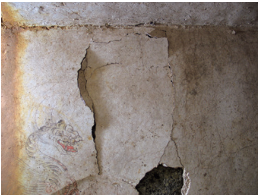
Fig. 2-20 西壁の漆喰層の剥離（白虎像右上）
