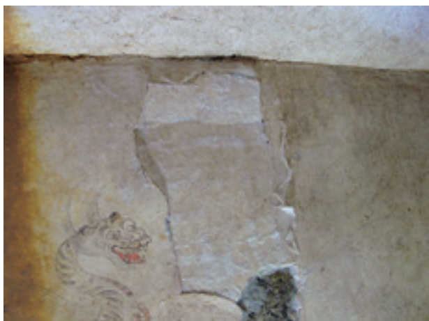
Fig. 3-6 取り外し箇所に HPC シートを貼り付けた。
