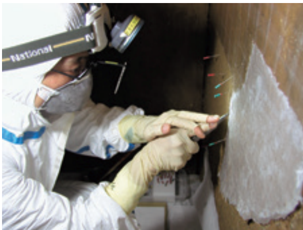
Fig. 3-47 午像のある漆喰部分の取り外し作業
