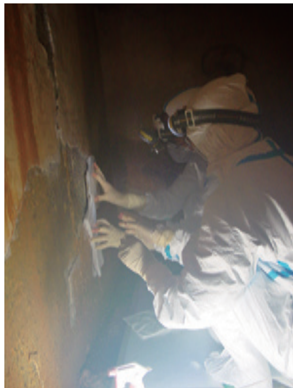
Fig. 3-8 取り外し部分と同じ形に切り抜いたポリエステル綿と PP 段ボールを、表面保護を施した壁面に貼り付けた。
