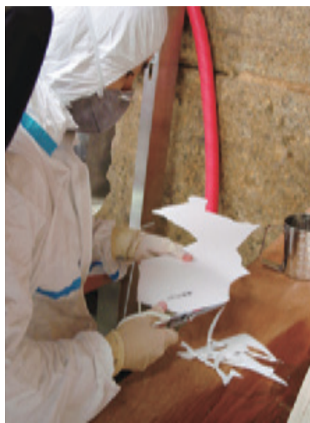
Fig. 3-5 取り外す壁面と同じ形に、表面保護の材料を切り抜いた。
