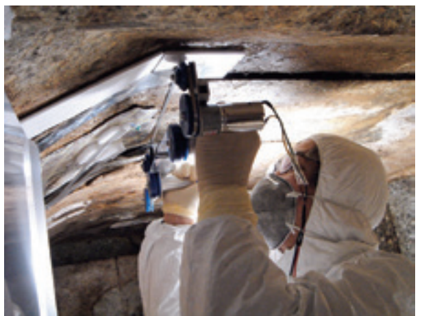
Fig. 3-87 ワイヤーソーによる無地部分の漆喰層取り外し。
