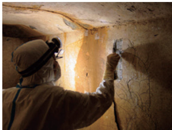
Fig. 2-17 HPC シートによる表面保護 (応急処置)
