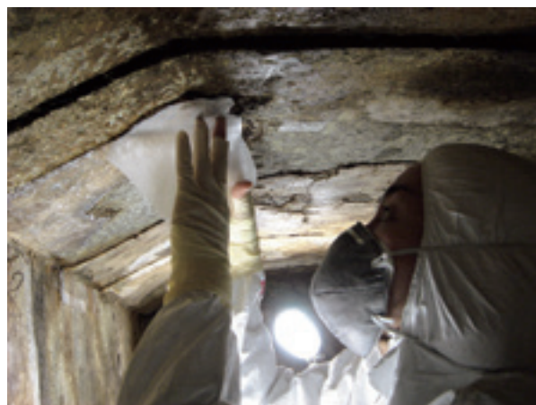
Fig. 3-79 天井の傾斜面の取り外し作業
