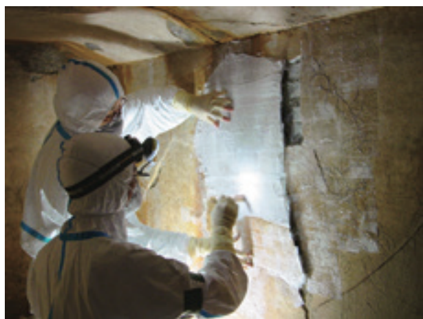
Fig. 3-7 滅菌ガーゼにより補強した。
