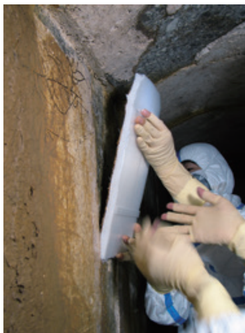
Fig. 3-10 漆喰を取り外した。
