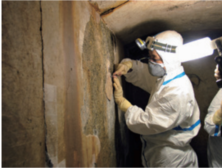
Fig. 3-19 白虎の前足部分の取り外し作業
