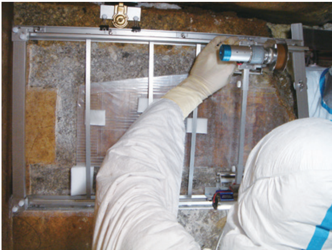
Fig. 3-63 ダイヤモンドワイヤーソーによる朱雀の取り外し
