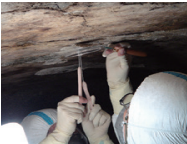
Fig. 3-84 歯科用シリコン型取り材、針金とシリコンシートを組み合わせ、見通しよく漆喰を押さえる道具を作製して使用した。
