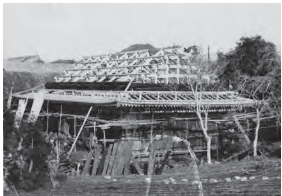
1. 現在の母屋の様子 手前はナガヤを民宿用に建て替えた建物 2. 背後の斜地から見た母屋 前面は海 3. 昭和34年（1959）、麦ガラ葺きから瓦葺きに大改修した当時の様子（吉田氏提供。以下、古写真はすべて吉田氏提供）
