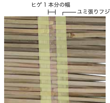
図3-13 ユミ張りフジの間をヒゲ1本分空ける
