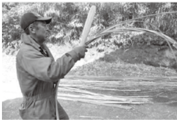
43. クミボウでタガを叩き調整する
