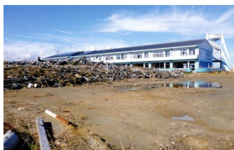
図 25 被災後の請戸小学校
