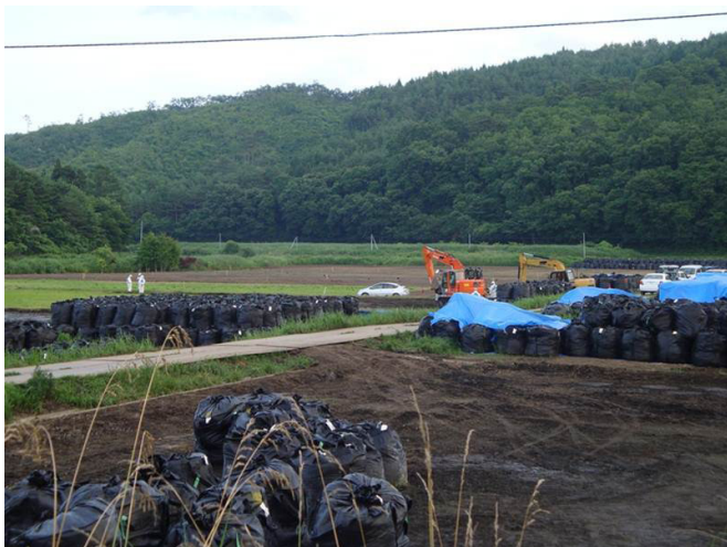
図 17 放射性廃棄物 (除染廃土) 仮置き風景 (2012年7月26日 飯館村)
