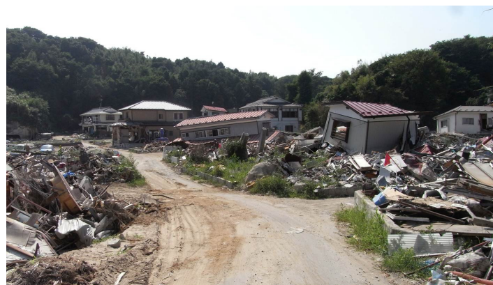
図12 壊滅的な被害を受けた集落
