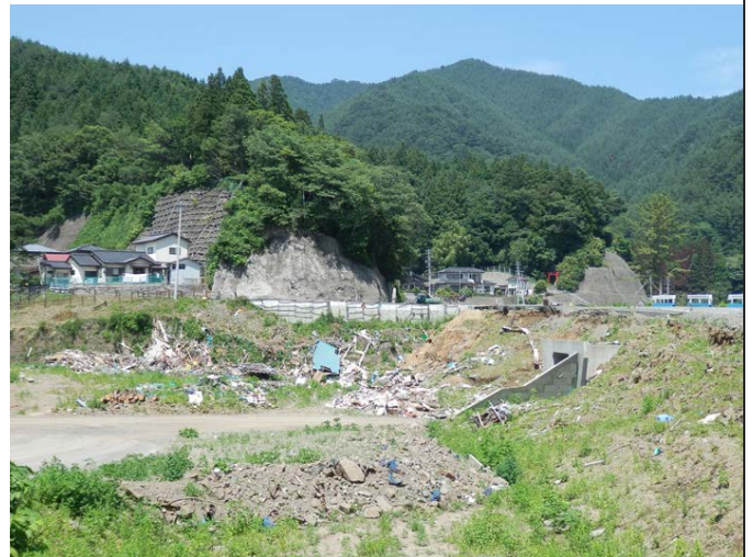
図 19 釜石市唐丹町の防潮堤
