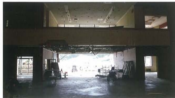
三陸公民館、がれき撤去後の内部の状況
