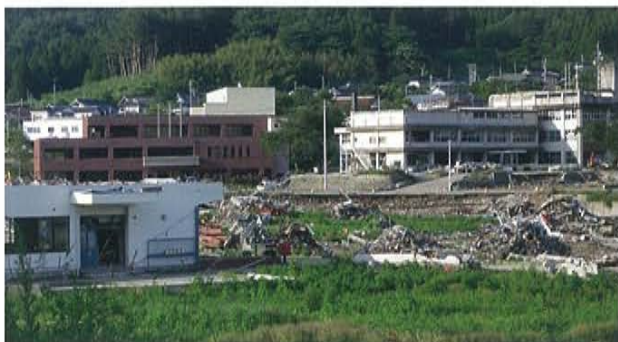
壊滅的被害を受けた大船渡市立三陸公民館図書室
