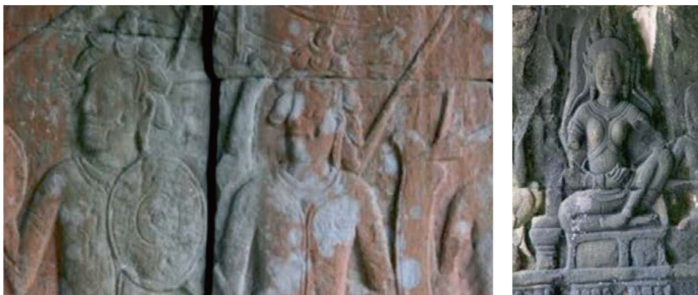
バイヨン寺院の浅浮き彫り表面に形成したバイオフィーム
