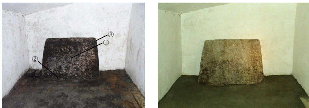
虎塚古墳石室の扉石の微生物発生（左）と紫外線照射と物理的除去後（右）の様子
