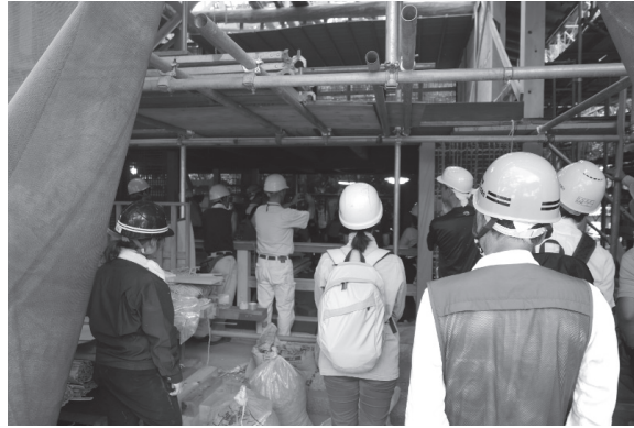
図 10 修理現場の公開
