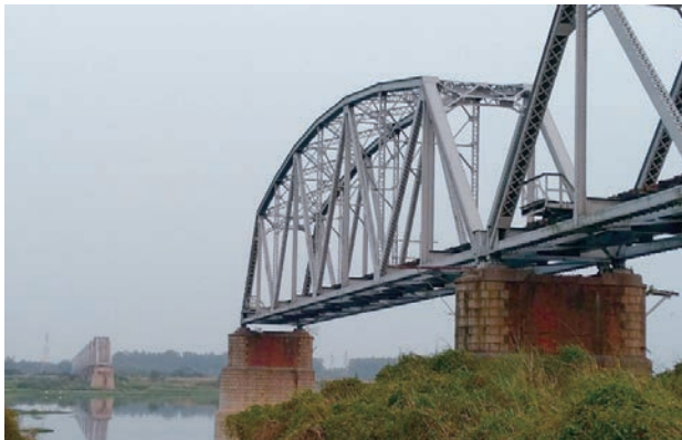
Photo174 橋の中央部が流出した橋梁の現状／橋中央處流失的橋樑現狀
