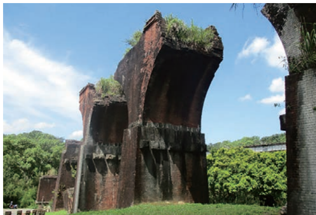
Photo115 震災で破壊された煉瓦造の旧魚藤坪橋残跡／因地震被破壞的紅磚造舊魚藤坪橋遺跡
