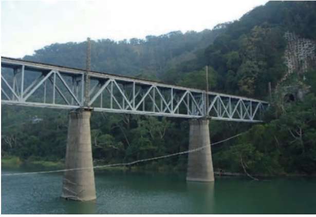
Photo3 縦貫鉄道旧山線の内社川上路式トラス橋／ 縦貫鐵路舊山線内社川上承式桁架橋
