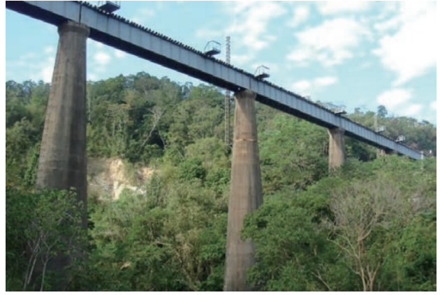
Photo4 縦貫鉄道旧山線の1935年の鉄道震災復興の新魚藤坪上路式鉸桁橋梁／縦貫鐵路舊山線於1935年鐵路震災復興重建後改為上承式鉸桁橋的新魚藤坪橋樑
