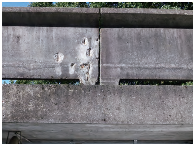
写真 64 コンクリート壁高欄の補修事例
