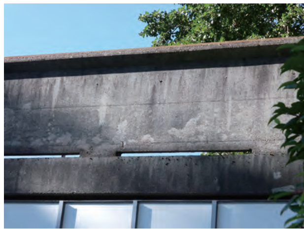
写真 65 コンクリート壁高欄の補修事例（オリジナルの色に近いため、違和感を感じさせない）
