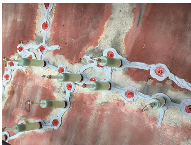
写真3-6：表面遮水壁の保護塗膜が剥離している状況 写真提供 東京電力ホールディングス株式会社
