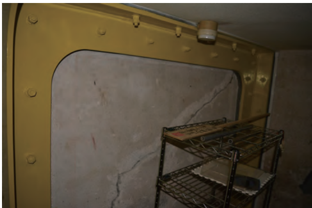
写真 16 門型鉄骨枠による補強（非公開エリア）
