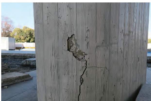
写真 6-3：擬似打放し仕上げ面の劣化・破損状況
