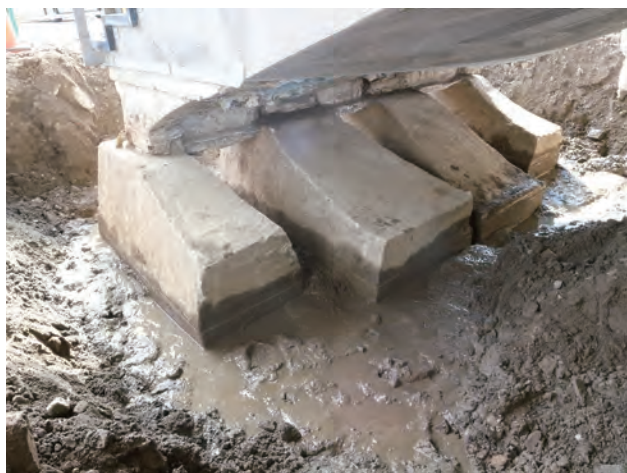
写真 19 階段下独立基礎 現状変更許可を得て撤去
