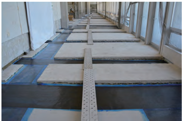
写真 20 二階床梁天端炭素繊維補強
