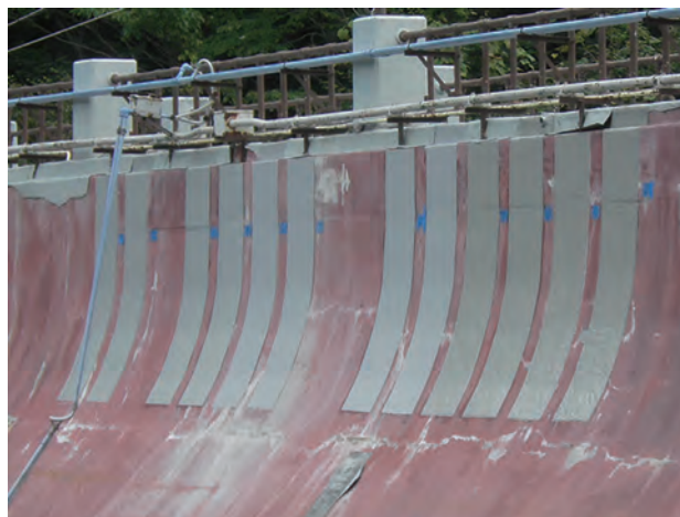
写真 3-4：試験施工した保護塗膜のモニタリング状況 写真提供 東京電力ホールディングス株式会社
