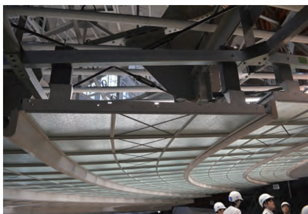
写真 28 新設ガラス繊維補強石膏（GFRG）パネル天井
