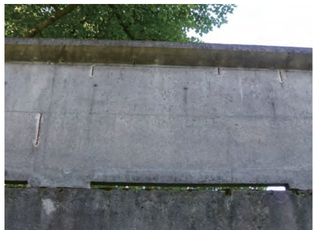
写真 68 鉄筋が錆びた状態 (3)
