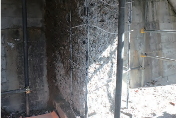
写真 3-8：劣化部を研り取り、表面洗浄後の状況 写真提供 東京電力ホールディングス株式会社
