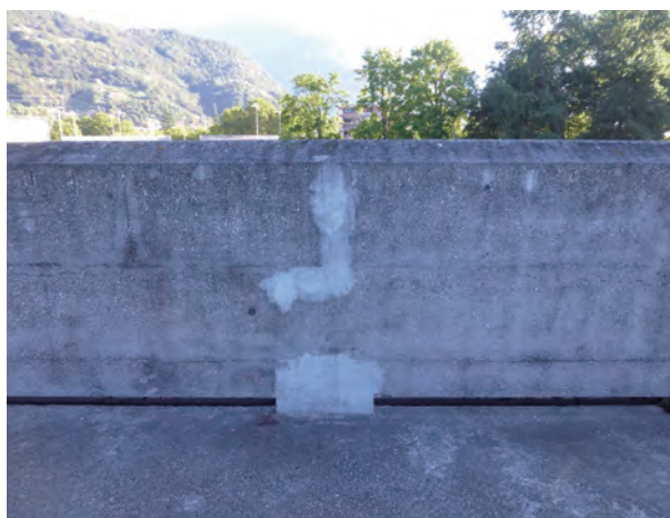
写真 63 コンクリート壁高欄の補修事例（補修部分が白く目立つ）
