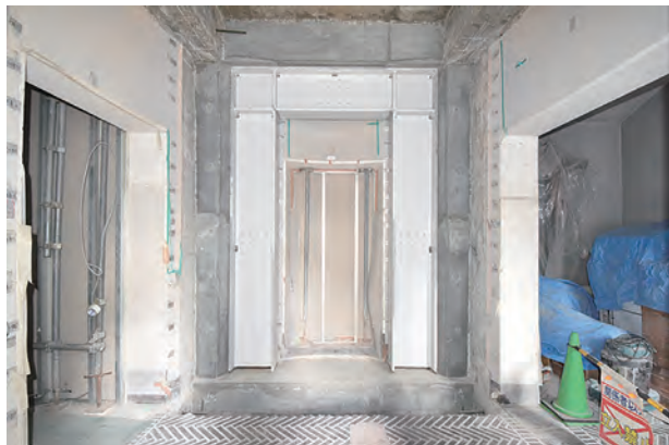
写真 5-16：小玄関の鉄骨補強
