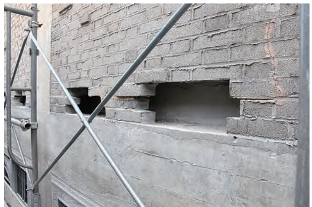
写真 5-2：聖堂二重壁部分（外壁モルタル煉瓦を一部外した状況） 写真提供 公益財団法人 文化財建造物保存技術協会
