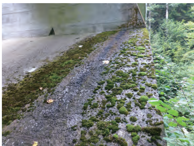
写真 14 アーチリブの排水システム
