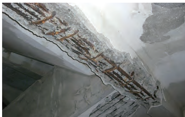
写真2 塩害による被害例写真(左 3 :(公社)日本コンクリート工学会、コンクリートのひび割れ調査、補修・補強指針 2009)より抜粋、 右:軍艦島建造物(65号棟):長崎市の特別な許可を得て撮影・掲載)
