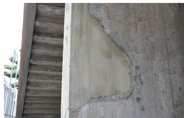
写真 5-13：圧入工法型枠撤去後の状況 写真提供 公益財団法人 文化財建造物保存技術協会
