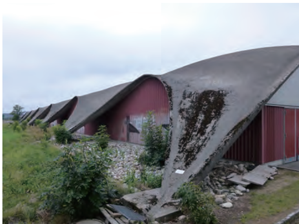
写真 51 6つのシェル屋根が連続した構造
