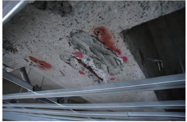
写真 6-7：仕上げ材によって補修箇所が隠れる部分では、補修範囲が明確に示せる仕上げ処理となっている。
