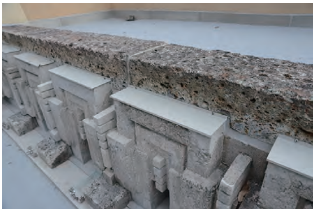
写真 1-3：擬石飾り上部に設置されたガルバリウムカラー鋼板水切底
