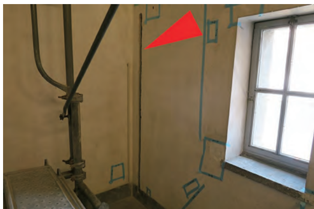
写真 5-17：準備室内に設置された耐震スリット（赤矢印の位置）
