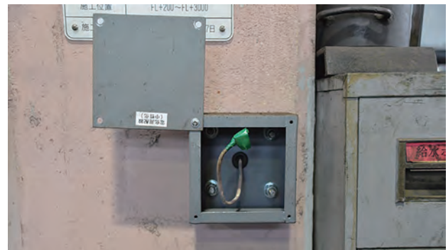
写真 7-9：モニタリングのため残された内部電極用の配線
