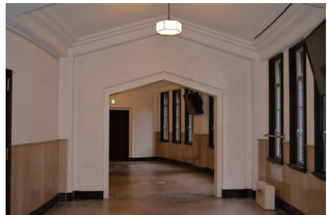
写真 27 同 完成 周囲意匠に合わせて尖頭形とした
