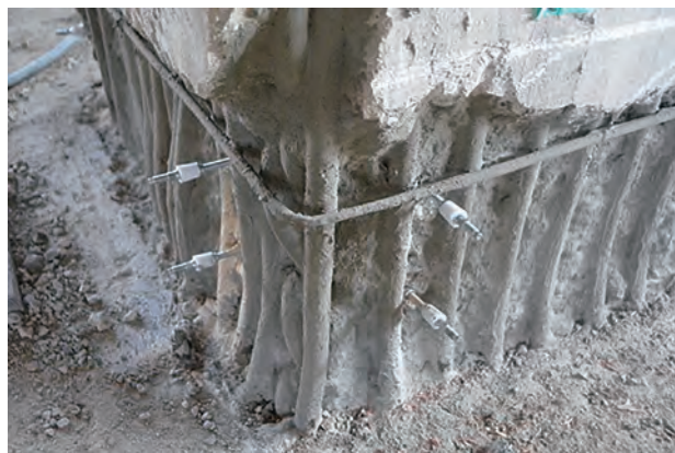
写真 2-4：ミニコンが設置された補修箇所 写真提供 公益財団法人文化財建造物保存技術協会
