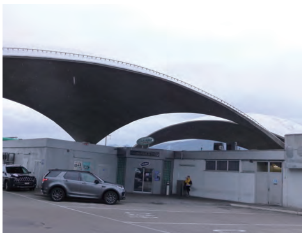
写真 55 ダイティンゲン南のコンクリートシェル屋根
