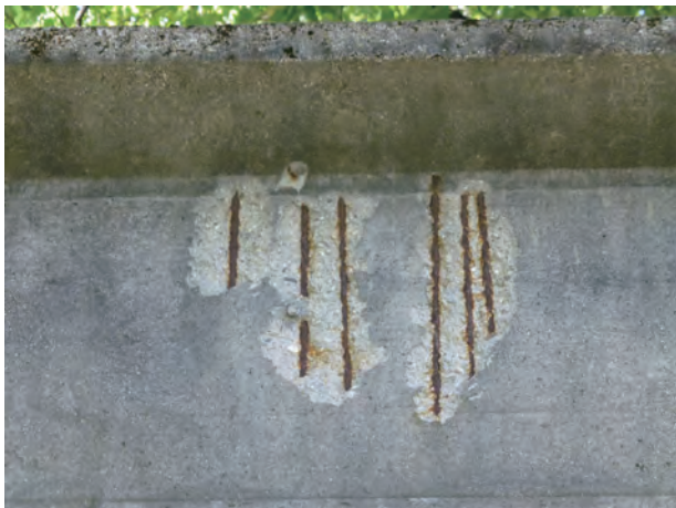
写真 66 鉄筋が錆びた状態 (1)
