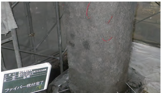
写真 7-3：ファイバー吹付完了 写真提供 西日本旅客鉄道株式会社
