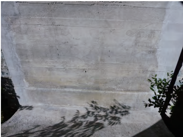
写真 48 補修した後のアーチリング下面
