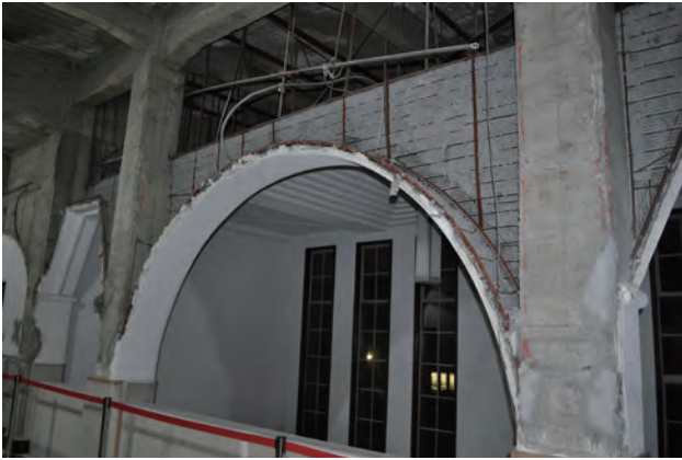
写真 23 鉄筋コンクリート造耐震壁 設置前 ラスモルタルによるアーチ装飾部解体
