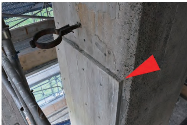
写真2-9:被り厚が不足している箇所に増し打ち補修した状況（赤矢印は増した被り厚を示す） 写真提供 公益財団法人 文化財建造物保存技術協会
