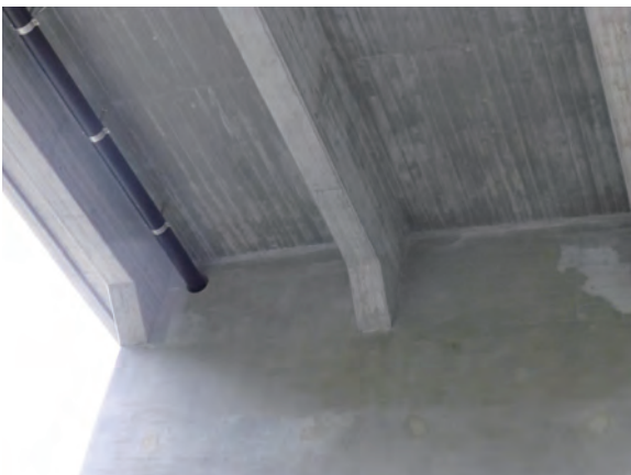
写真 21 排水管の後施行（その 1）
