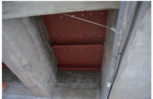
写真 6-8：鋼材と既存躯体との間にグラウト材を充填した状況
