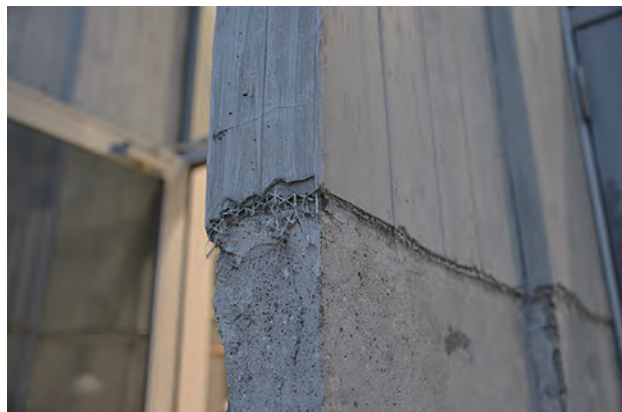
写真 6-4：仕上げ材の除去（構造躯体と仕上げ材を確認できる）
