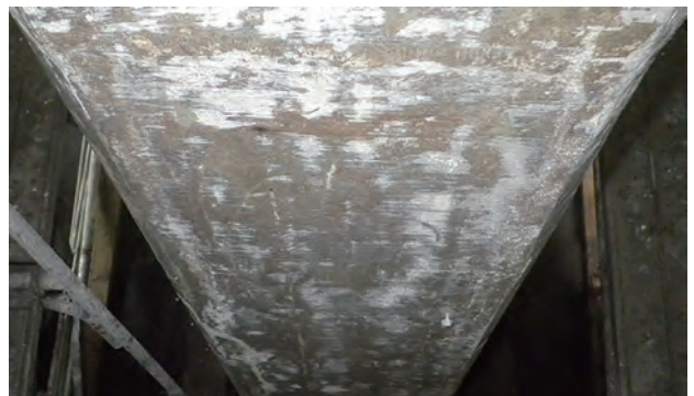
写真 7-5：再アルカリ化システム撤去後 写真提供 西日本旅客鉄道株式会社
