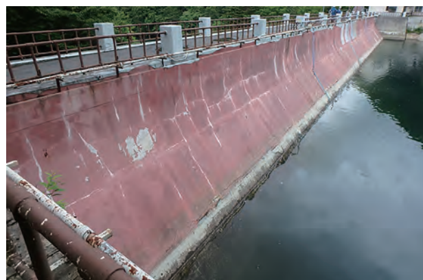
写真 3-2：表面遮水壁の保護塗膜が剥離している状況 写真提供 東京電力ホールディングス株式会社
