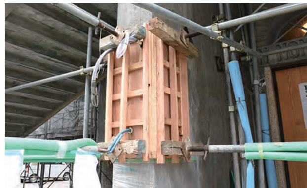
写真 5-12：圧入工法による施工状況 写真提供 公益財団法人 文化財建造物保存技術協会
