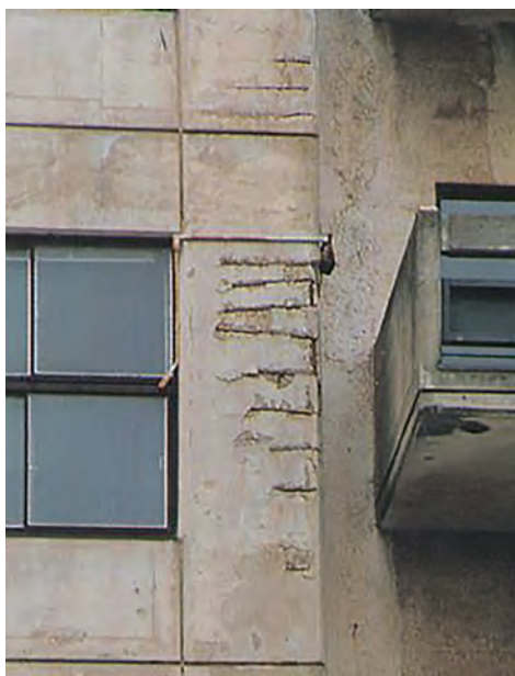
写真3 中性化による被害例写真 3
