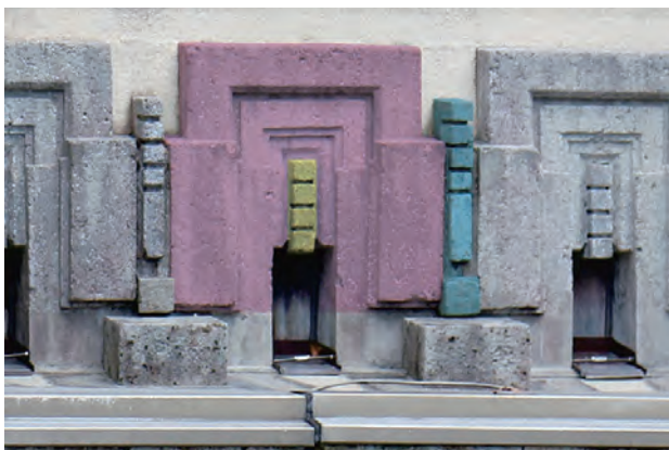
写真 1-2：A タイプ擬石飾り全 3 パーツの組み合わせ（赤のパーツが現場打設）写真提供：株式会社淀川製鋼所
