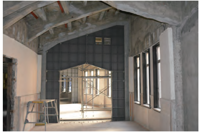
写真 26 講堂廻り廊下 鉄骨パネル壁 施工中
