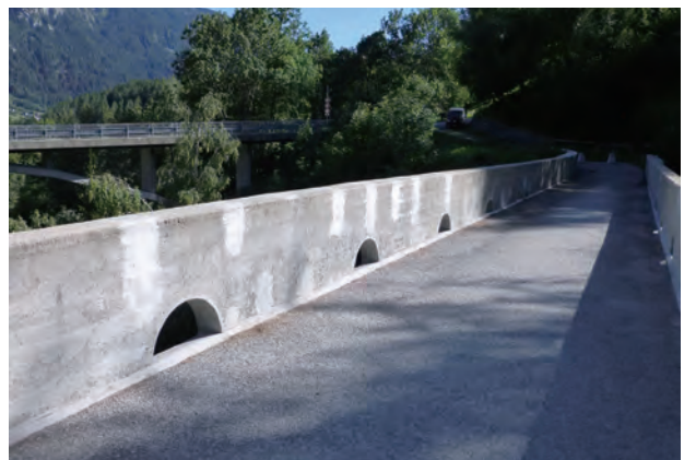
写真 46 橋面排水を外側に流さない処置
