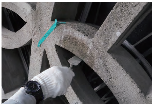
写真 5-9：プレキャストコンクリート補修状況 写真提供 公益財団法人 文化財建造物保存技術協会
