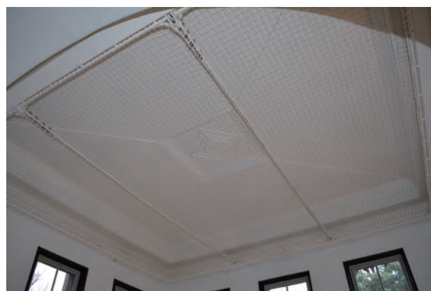
写真 29 階段室漆喰天井落下防止ネット
