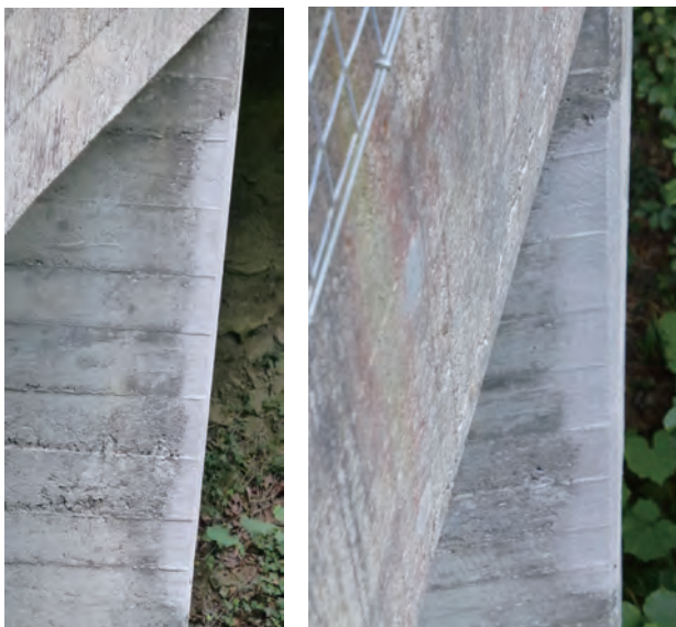
写真15 鉛直壁の補修
