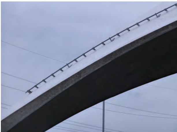
写真57 雪止めの設置状況
