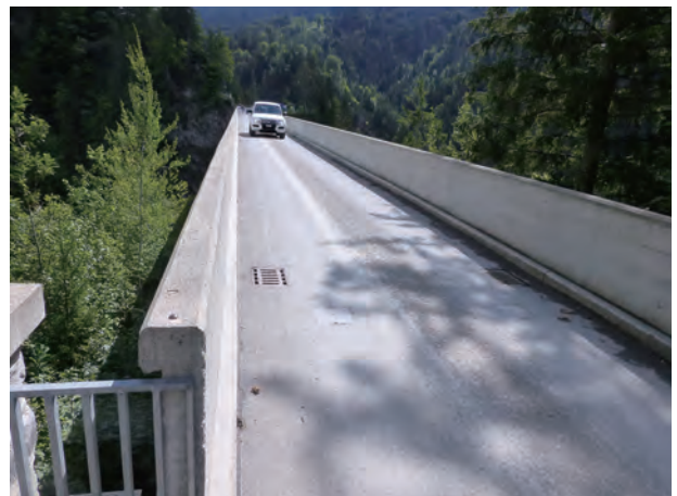
写真 34 橋面の排水方法（排水桝の設計）
