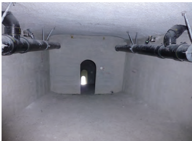
写真 35 桁内の排水管配置の現状
