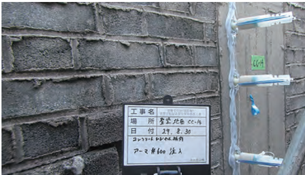
写真 5-6：セメントスラリー低圧注入工法（外壁部施工状況） 写真提供 清水建設株式会社広島支店
