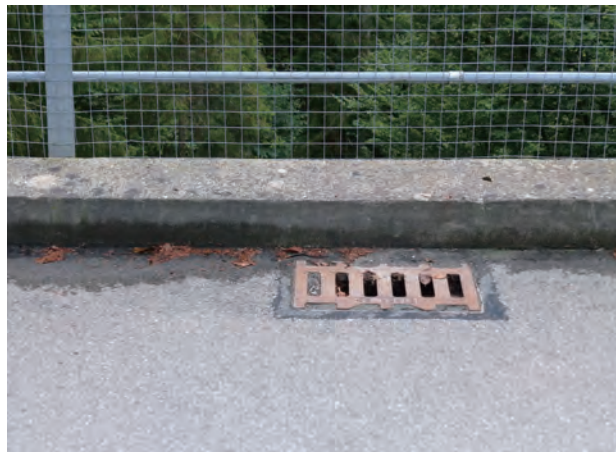
写真 13 シュバントバッハ橋の排水桝（曲線内側中央）
