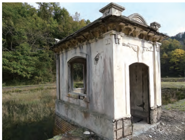
写真 2 修理前の制水井上屋 2 号 最も劣化が進んでいた。
