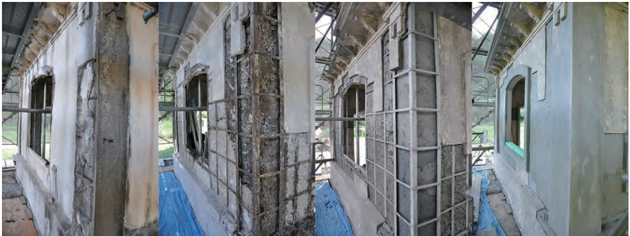
写真 4-4～7：左①制水井 1 号上屋修理前の状況、左②躯体斫り、左③鋼材防錆処理・下地調整、左④モルタル断面修復 (出典 『重要文化財 旧美敷水源地下水道施設 保存修理工事報告書』、p.89)
