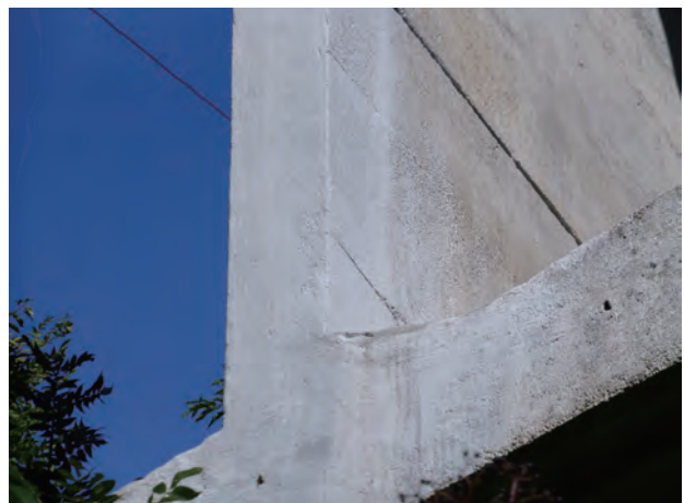
写真 47 補修した後の鉛直壁端部
