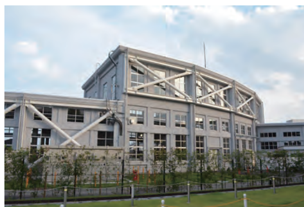
写真6 外部鉄骨ブレース補強
