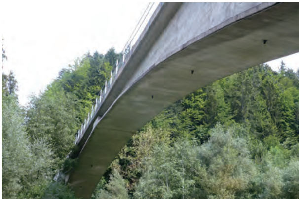
図2 橋面排水柵から排水管を使ってアーチ下面に排水する排水管のレイアウト (画像提供: ローザンヌ工科大学、Prof. Eugen Brühwiler)
