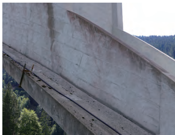
写真 38 北側のコンクリートの汚れ状況
