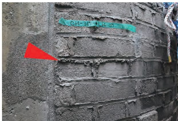
写真 5-10：モルタル煉瓦補修状況 写真提供 公益財団法人 文化財建造物保存技術協会
