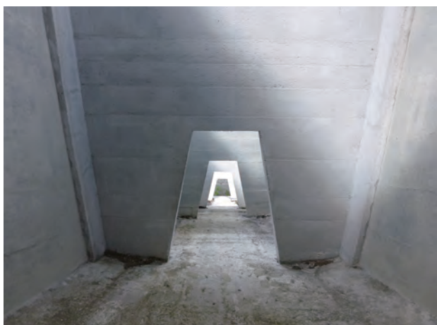
写真 36 アーチリングの桁内の排水方法
