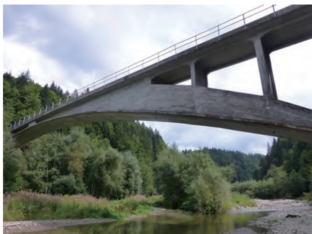
写真6 アーチリング下面の補修事例(新しく補修したコンクリート表面に木製型枠の年輪の模を再現している。)
