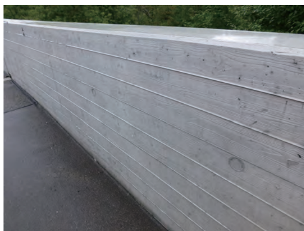
写真 26 コンクリート表面の木製川枠の再生
