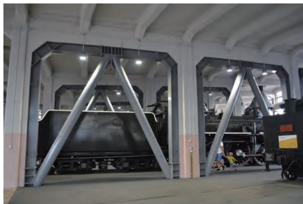
写真5 内部鉄骨ブレース補強
