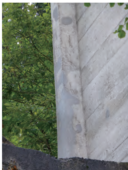
写真7 鉛直壁の補修事例(オリジナルのコンクリートの色と大きな差がない)
