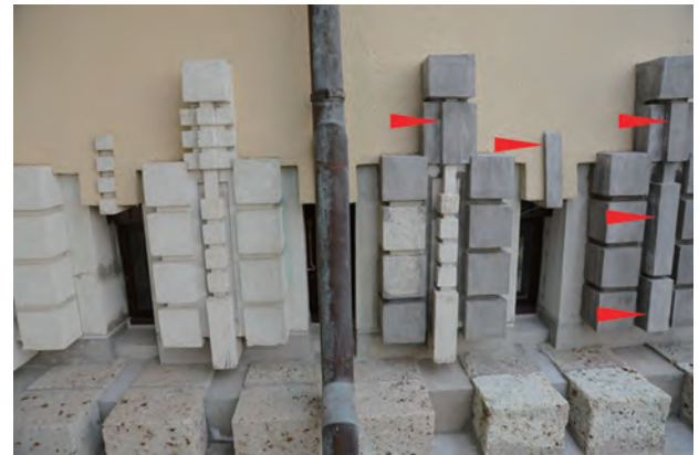
写真 1-5：詳細意匠の修復が省略された B タイプの擬石飾り（赤矢印で示す箇所等）
