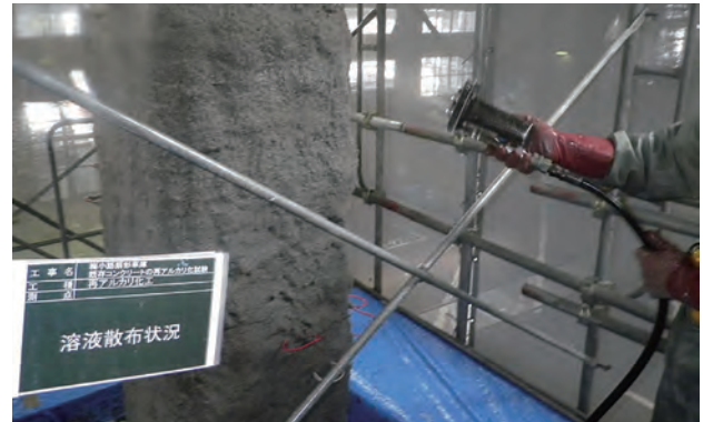
写真 7-4：電解質溶液散布状況 写真提供 西日本旅客鉄道株式会社
