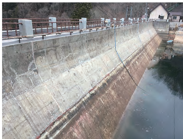
写真3-7：凍結劣化が発生した扶壁（過去の表面補修が剥離） 写真提供 東京電力ホールディングス株式会社
