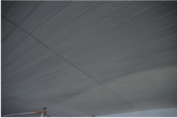
写真 6-5：補修後の疑似打放し仕上げ
