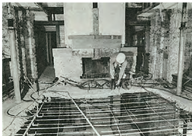
写真 17 2階スラブ打替え スラブ解体（『重要文化財旧山邑家住宅（淀川製鋼迎賓館）保存修理工事報告書』（株式会社淀川製鋼所、平成元年（1989）2 月）から転載）
