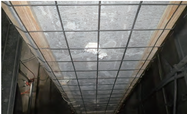
写真 7-2：外部の仮設陽極設置状況 写真提供 西日本旅客鉄道株式会社
