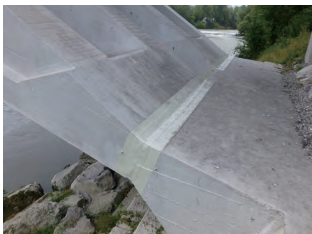
写真 24 3 ヒンジの補修
