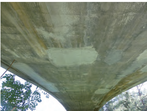
写真 49 補修した後の鉛直壁下部
