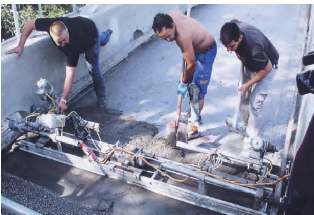
写真 44 UHPRFC を 2 層とした橋面防水工事（現地の説明パネル撮影）
