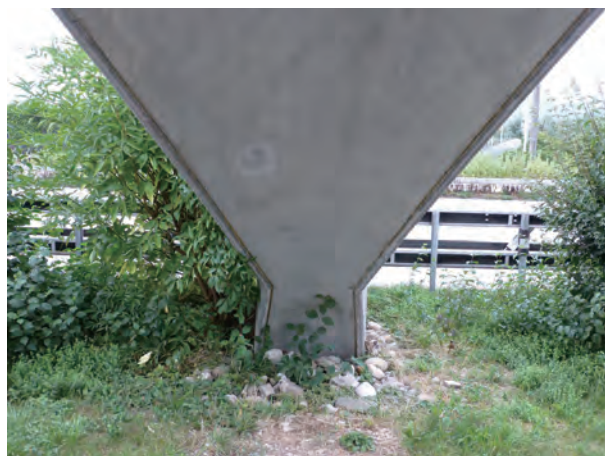
写真58 コンクリートシェルの地盤アンカー部
