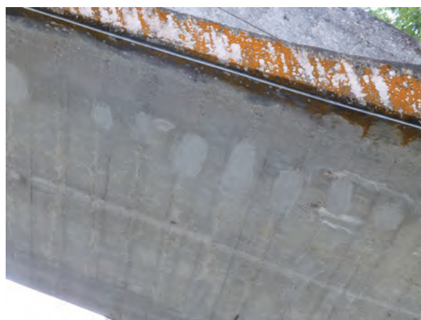
写真8 アーチリングの補修事例(オリジナルのコンクリートの色と大きな差がない。アーチリング端部に水返しを施工。)
