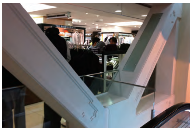
写真7 高島屋東京店 意匠的に工夫したブレース補強
