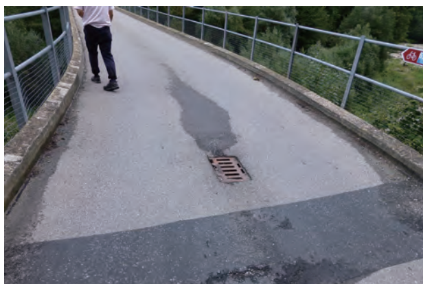
写真3 橋面排水装置（道路端部中央に排水樹を設置）と取り換えた手摺
