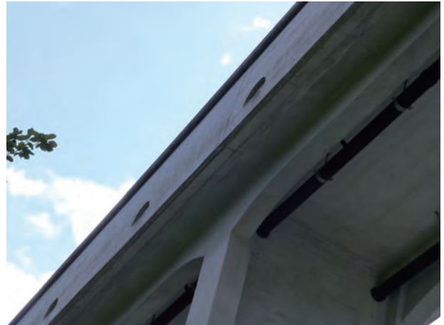
写真 33 橋の外側から見た排水孔
