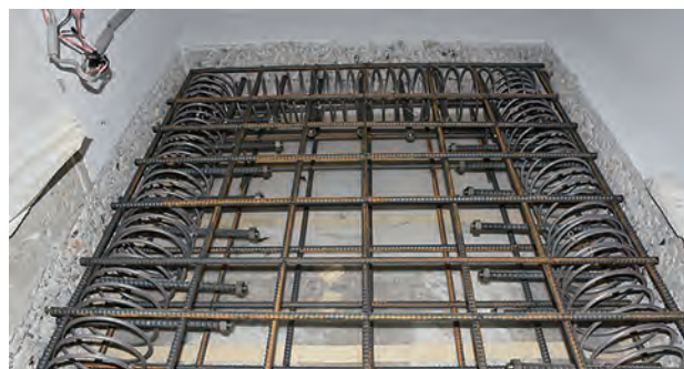
写真 5-15：玄関倉庫の RC 壁配筋完了写真
