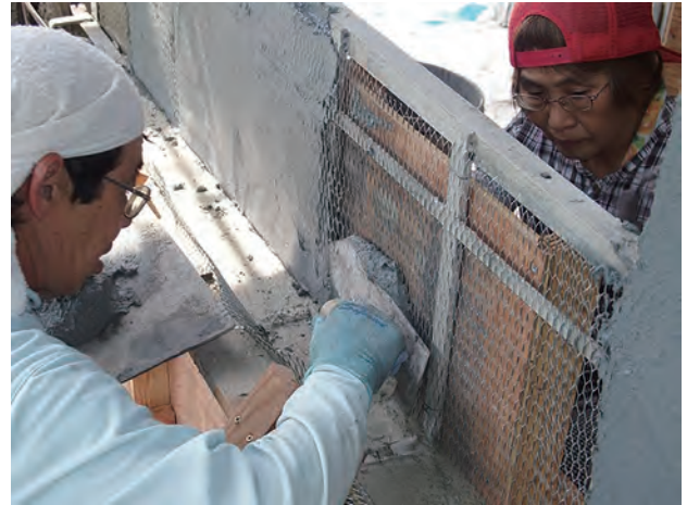
写真 4-1：鉄骨鉄網モルタル造 出典 『重要文化財 旧美歎水源地水道施設 保存修理工事報告書』、p.87
