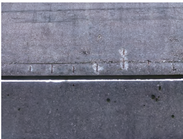
写真 67 鉄筋が錆びた状態 (2)
