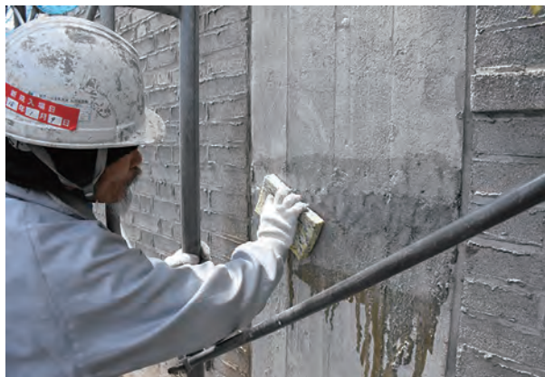
写真 5-8：コンクリート補修部を美装材で措置している状況 写真提供 公益財団法人 文化財建造物保存技術協会
