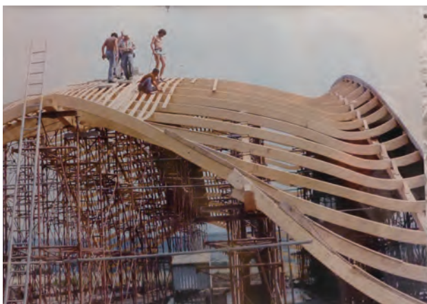
写真 53 施行中の型枠支保工（現地の説明パネル撮影）
