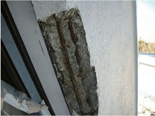
写真 4 トップライト部の鉄筋腐食
