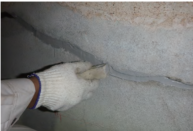
写真 5-5：Uカットシール充填工法（内陣天井部施工状況） 写真提供 清水建設株式会社広島支店
