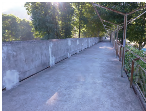
写真 62 コンクリート壁高欄の補修事例（補修部分が白く目立つ）
