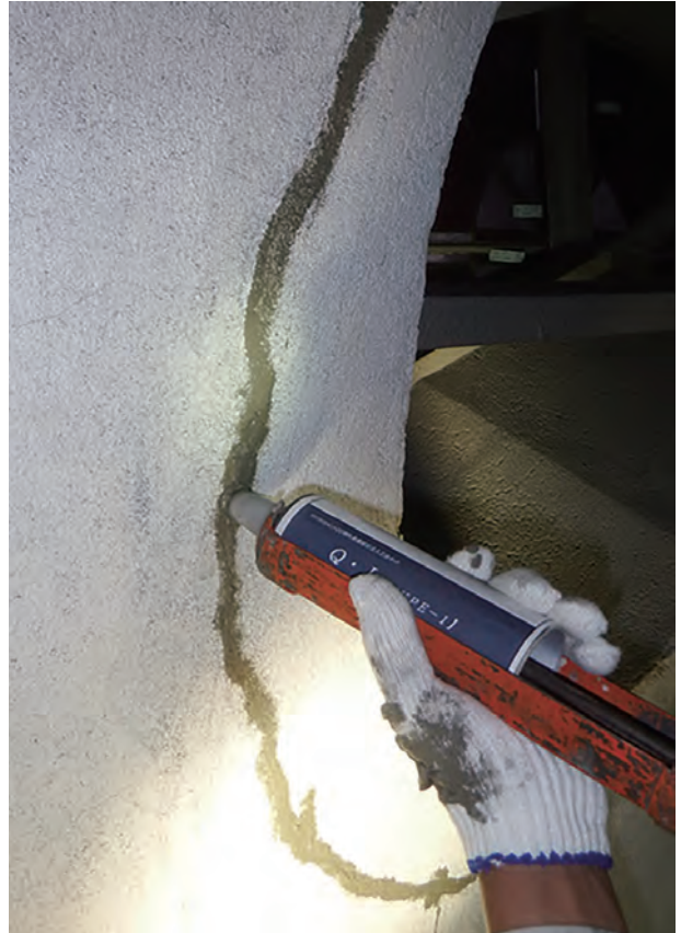
写真 5-4：超微粒子セメント注入工法（内陣天井部施工状況） 写真提供 清水建設株式会社広島支店
