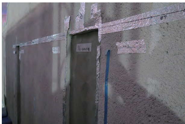
写真 5-18：聖堂大祭壇に設置された耐震スリット（スリット部をモルタル下塗りした状況、スリット部分は最終的に仕上げ処理され表面には現れない）
