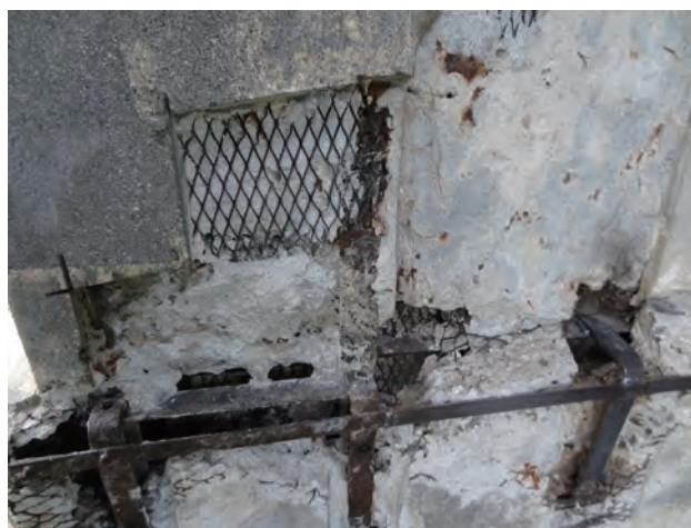
写真 3 オリジナルの菱形形状のメタルラスと鉄骨部材 劣化した表面モルタルを研ったところ。
