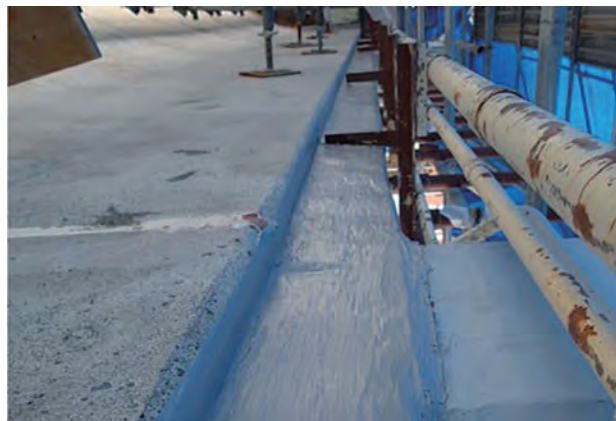
写真3-5：天端部に防水塗膜を塗布した状況 写真提供 東京電力ホールディングス株式会社
