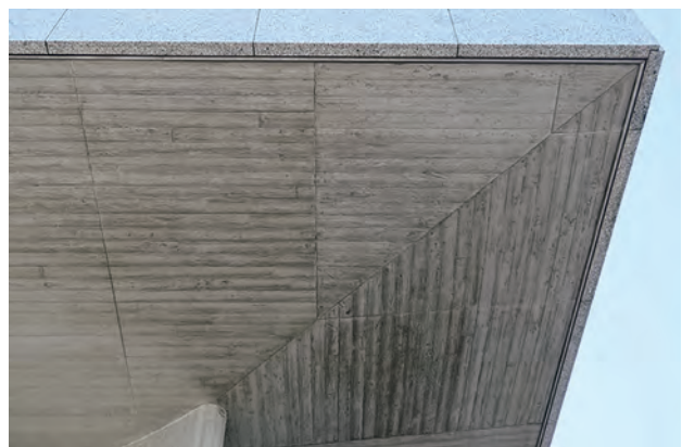
写真 6-2：擬似打放し仕上げ面（平成18年（2006）に実施された補修後の状況）
