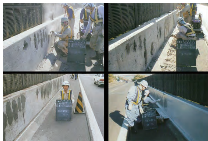
図7 断面修復工法のコンクリート 3 の概要図（左上）、作業写真（左下）、工程（右）
