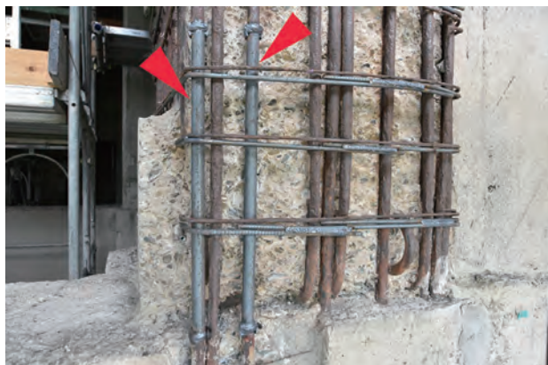
写真2-8:エンクローズ溶接された鉄筋（施工された鉄筋を赤矢印で示す） 写真提供 公益財団法人文化財建造物保存技術協会
