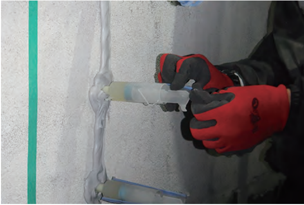
写真 5-3：エポキシ樹脂低圧注入工法（内陣天井部施工状況） 写真提供 清水建設株式会社広島支店
