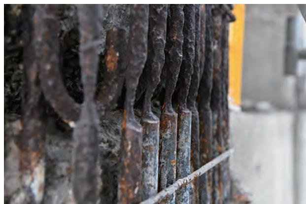
写真 2-6：鉄筋の腐食状況 写真提供 公益財団法人文化財建造物保存技術協会
