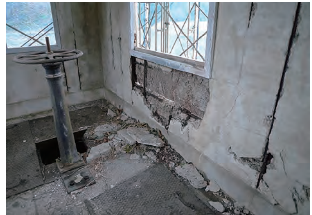
写真 4-3：制水井 2 号上屋内壁劣化破損状況 出典 『重要文化財 旧美歎水源地水道施設 保存修理工事報告書』、p.95
