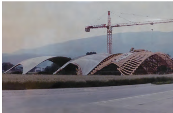
写真 54 施行中のシェルコンクリート（現地の説明パネル撮影）
