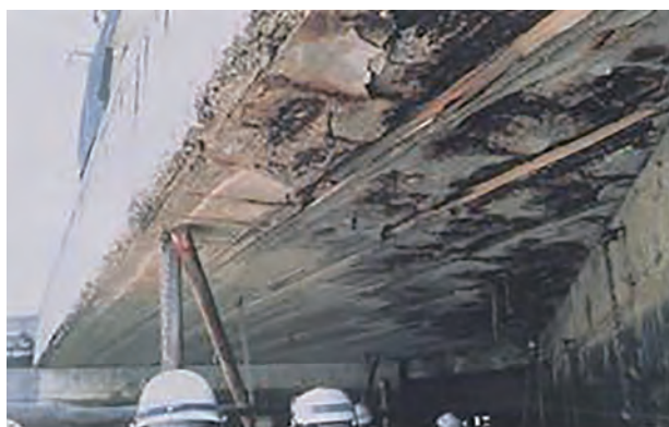
写真2 塩害による被害例写真(左 3 :(公社)日本コンクリート工学会、コンクリートのひび割れ調査、補修・補強指針 2009)より抜粋、 右:軍艦島建造物(65号棟):長崎市の特別な許可を得て撮影・掲載)
