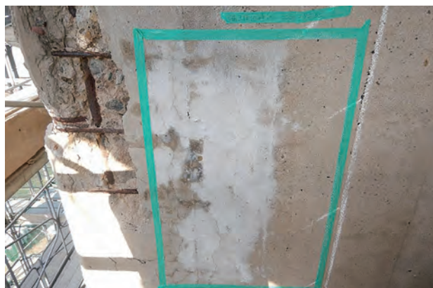
写真 2-10：亜硝酸系浸透防錆剤＋ケイ酸塩系表面含浸剤を試験塗布後に発生した白華の状況
