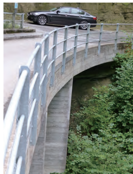
写真16 銅製手摺の交換
