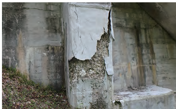
写真 3-3：凍結劣化が発生した扶壁（過去の表面補修が剥離） 写真提供 東京電力ホールディングス株式会社
