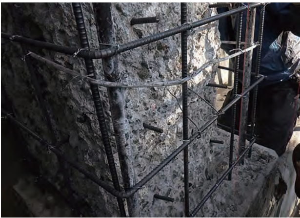
写真 3-9：挿筋後の状況 写真提供 東京電力ホールディングス株式会社
