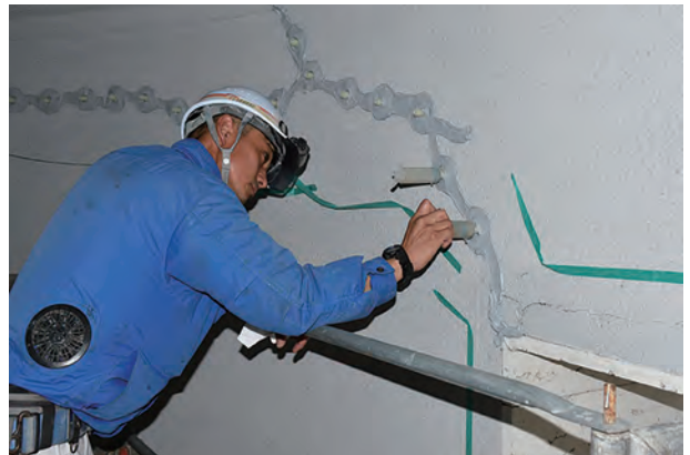
写真 5-7：セメントスラリー低圧注入工法（内壁部施工状況） 写真提供 公益財団法人 文化財建造物保存技術協会
