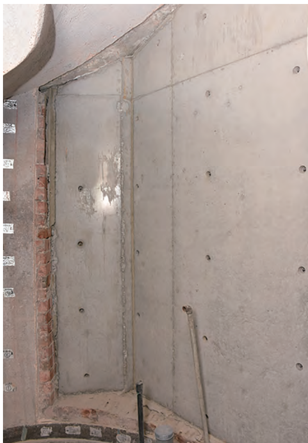
写真 5-14：階段室の RC 壁補強
