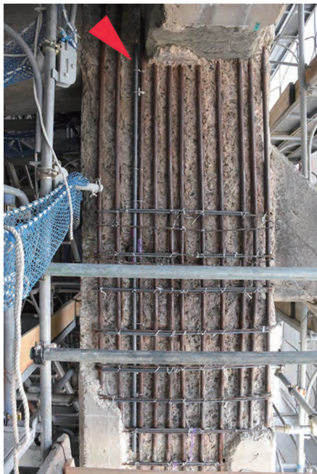
写真 2-7：写真⑦ 挿筋された補修範囲（挿筋を赤矢印で示す） 写真提供 公益財団法人文化財建造物保存技術協会
