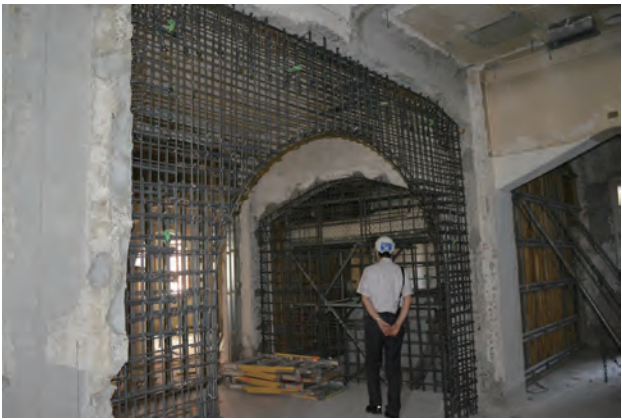
写真 24 鉄筋コンクリート造耐震壁 鉄筋配筋
