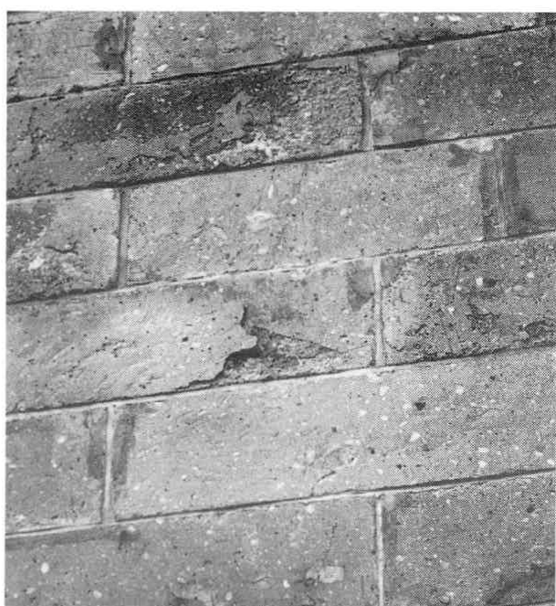
同 石壁南面の凍害による剝離と剝落
