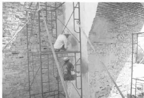
トランパントラン寺院保存修復事業
