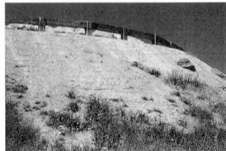
テルの補強整備
