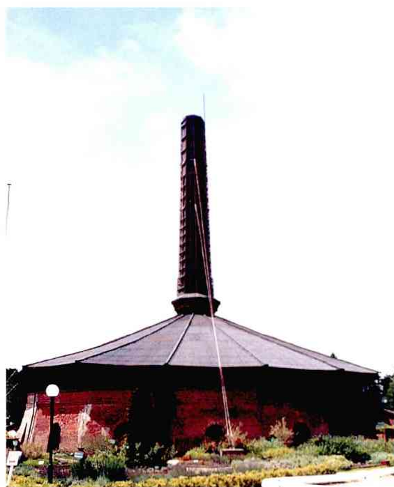
重要文化財・旧下野煉瓦製造ホフマン式煉瓦焼成輪窯（30頁参照）
