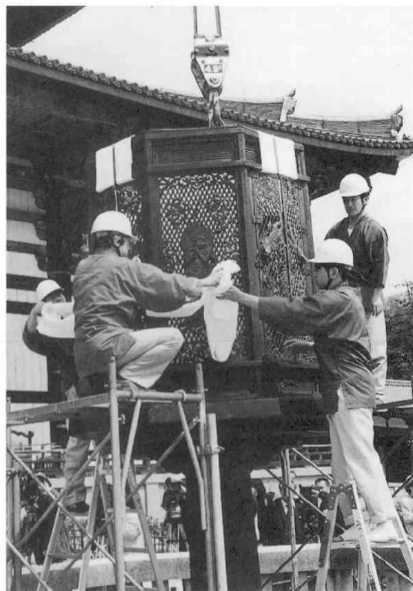
八角灯籠 防錆処理後組立作業
