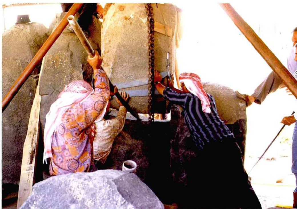
大型石彫物の修復作業
