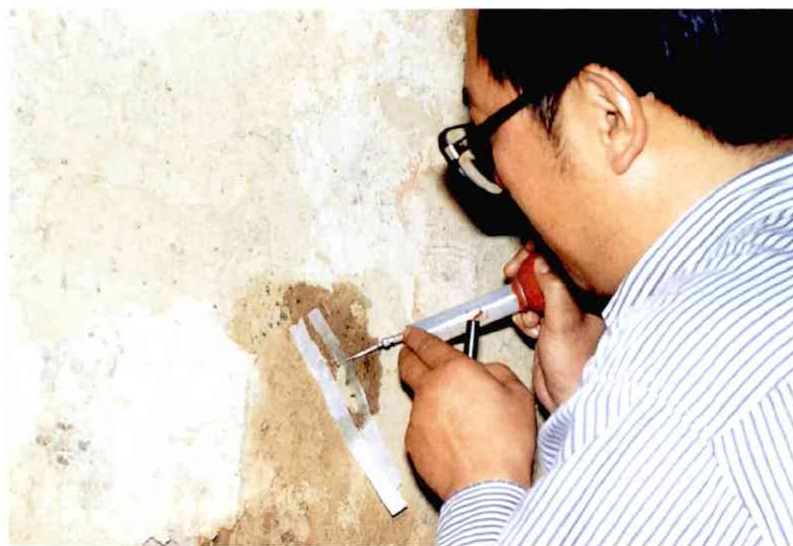
53 窟における泥下地の剥落止めテスト
