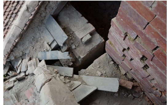
図3-1-15 モハン・チョク南棟（左）とアガンチェン寺本体（右）との間に生じた空隙
