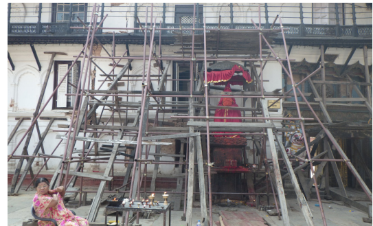
図 2-2-4 補強工事着手前（5月）（6月）
