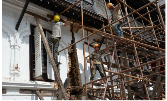
図 2-2-8 アガンチェン寺階下外部補強：単管追加・組替 (6月)
