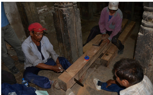
図 2-2-5 アガンチェン寺階下1階内部補強：木材加工（6月）
