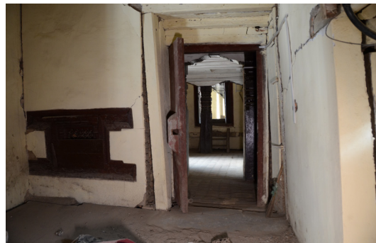
図 3-1-5 アガンチェン寺直下南側外壁（ハヌマン門上） 3 階
