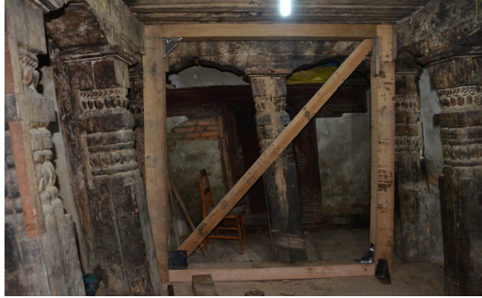
図 2-2-7 内部補強のための木材の設置 (6月)
