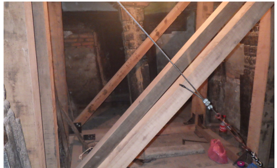
図 2-2-10 内部補強：ワイヤーとターンバックルの設置 (9月)
