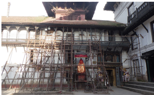
図 2-2-11 作業完了：全景 (9月)
