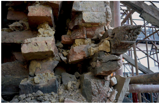
図 3-1-4 アガンチェン寺直下 2 階 外壁北出隅の蛇腹
