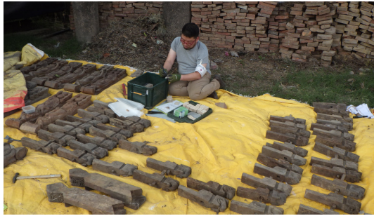
図 2-2-13 回収部材への番付作業の様子
