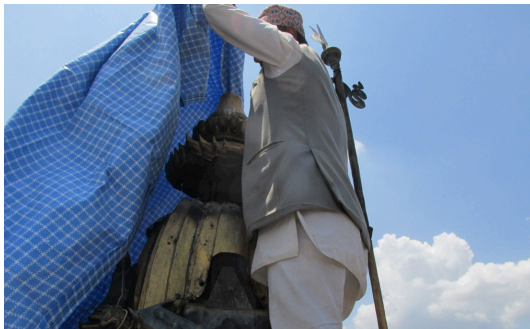
図 2-2-3 尖塔の雨水対策（5月）
