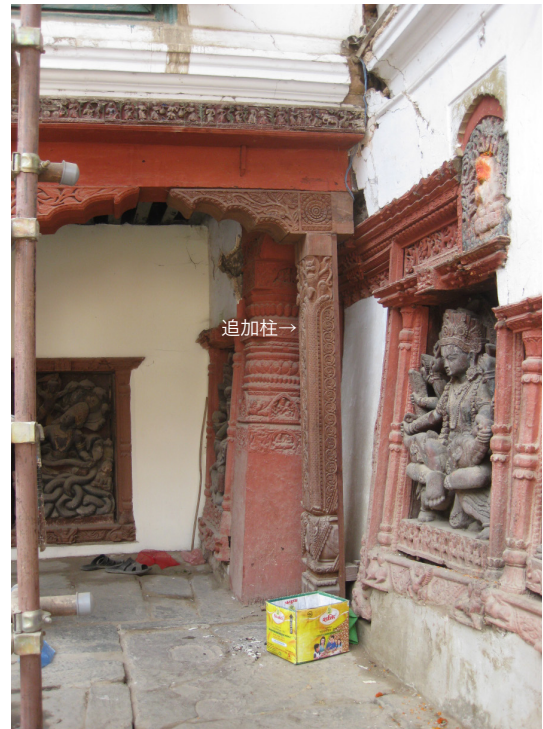
図3-1-17 モハン・チョク南棟北面西端に補足された柱
