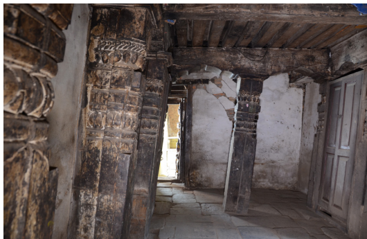
図3-1-12 アガンチェン寺直下1階室内
