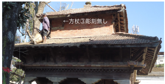
図 2-2-20 屋根工事施工写真 (2014年2月12日撮影) ERCO 提供
