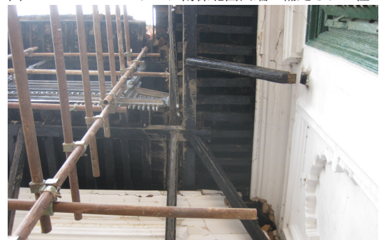
図3-1-19 モハン・チョク南棟北面バルコニー見上げ
