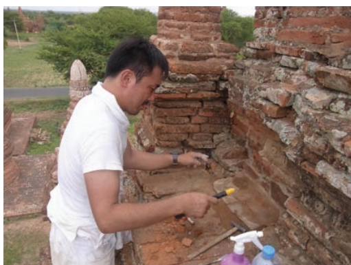
煉瓦欠損箇所の応急処置
