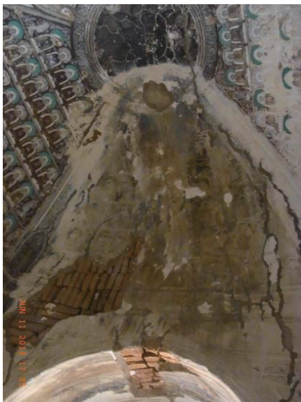
屋根の雨漏りによる壁画面の崩落
