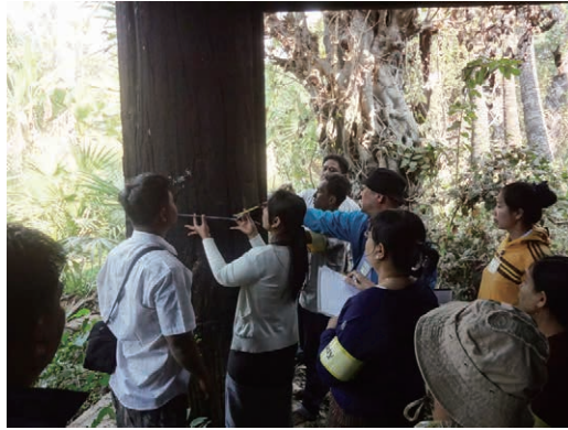
実測調査：柱径をミリ単位で読み取る
