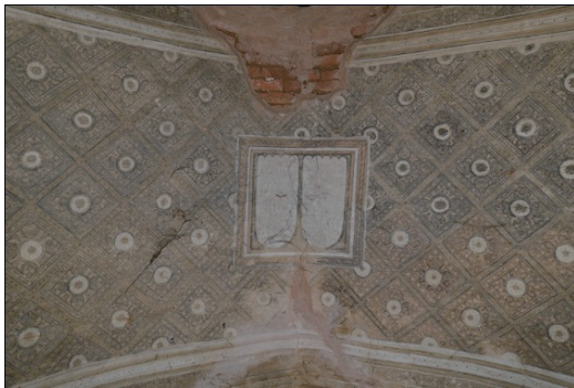
雨漏りによる天井壁画の崩落
