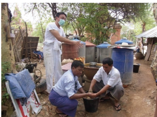
修復実習：材料調整（川砂の洗浄）
