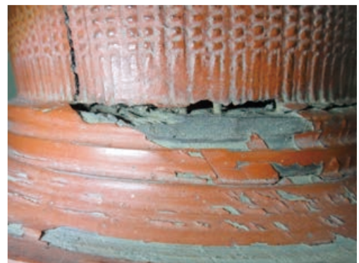
高台接合部の損傷
