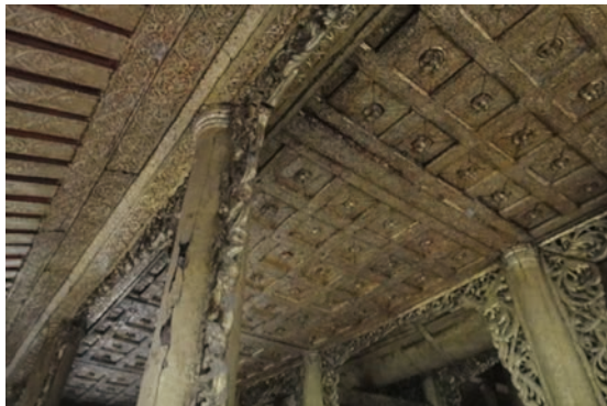
雨漏りによる損傷
