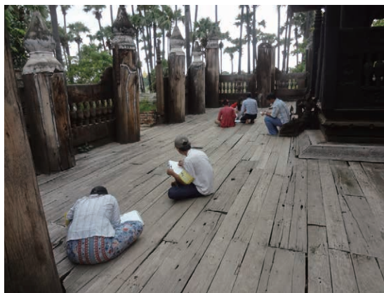
床板の伏図作成
