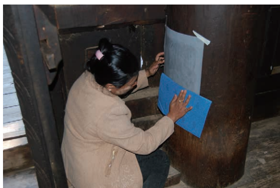
仕様調査：柱表面に残る工具痕の擦り拓
