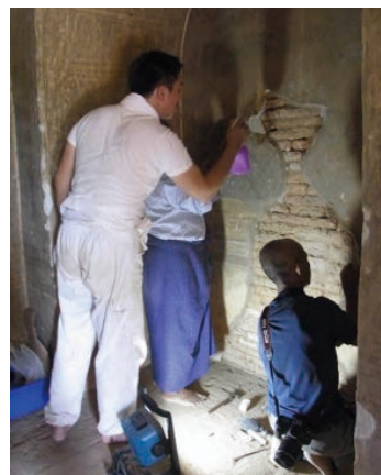
修復実習：旧補填材料の除去とエッジング
