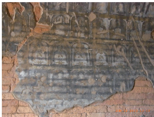
煉瓦目地からの浸水による壁画面の汚損
