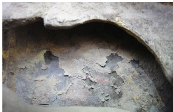
漆塗膜の剥離と剥落（僧院東側外壁）
