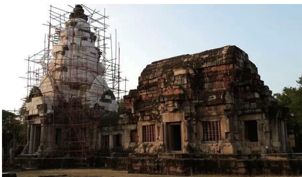
プラサート・パノム・ワンの屋蓋修復 The restoration of the roof of Prasat Phnom Wan
