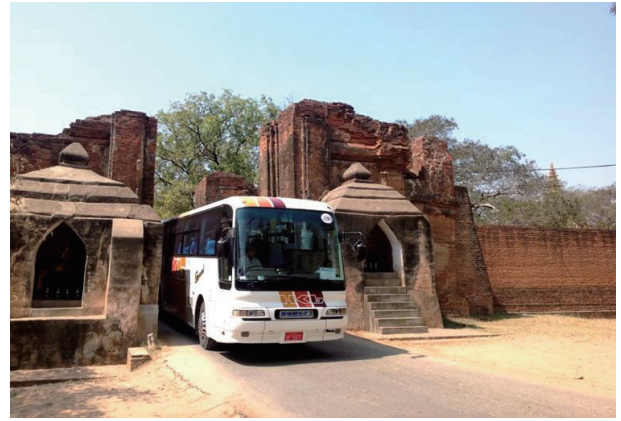
観光バスの通過によって損傷を受ける古代建造物 Ancient monument damaged by a tourist bus
