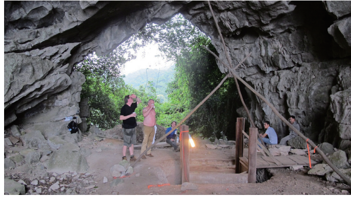
Fig.5 チョン洞窟の発掘坑の保護のために架けられた仮の支保工 Temporary protected shoring for the excavated pit at Trong cave
