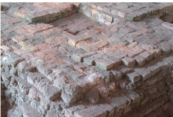
Fig.12 ゴータップ遺跡 BCX 建築遺構の煉瓦造基礎劣化状況 Deterioration of brick foundation, BCX architecture, Go Thap site
