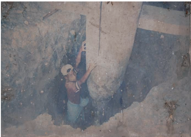
写真 14 ミンディン僧院の掘立柱（修理時の古写真）
