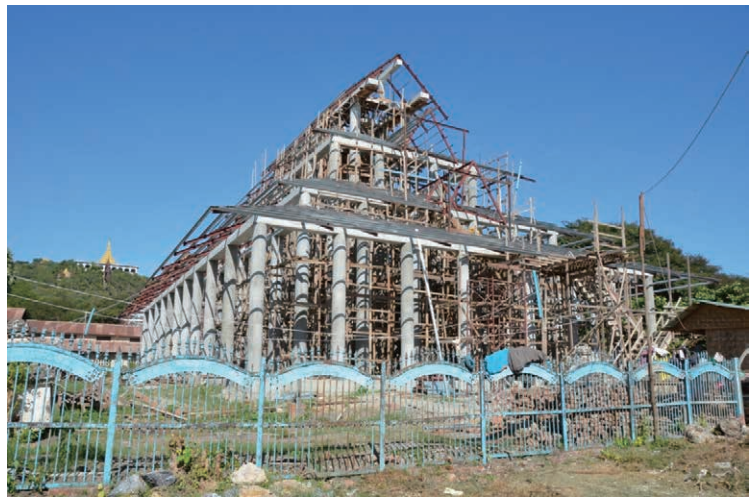
写真 46 RC 造で再建中の王室寺院（マンダレー）
