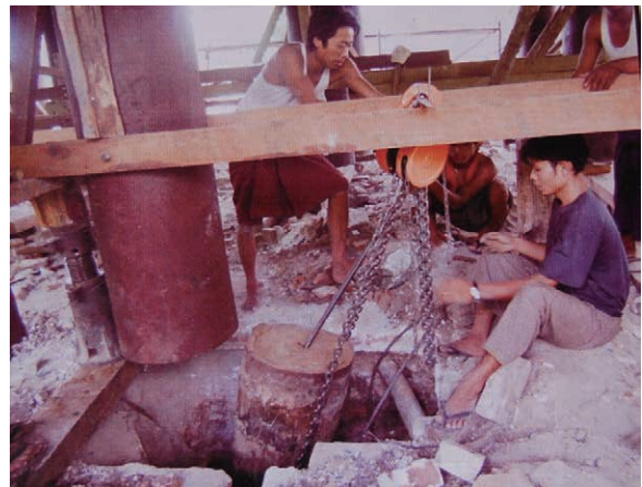
写真19 柱根元の切断作業 (マンダレーのザヤット修理工事時)
