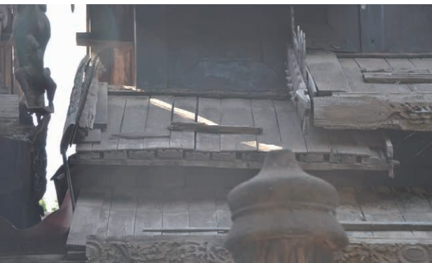
写真38 流板葺（バガン・ナッタウン僧院）
