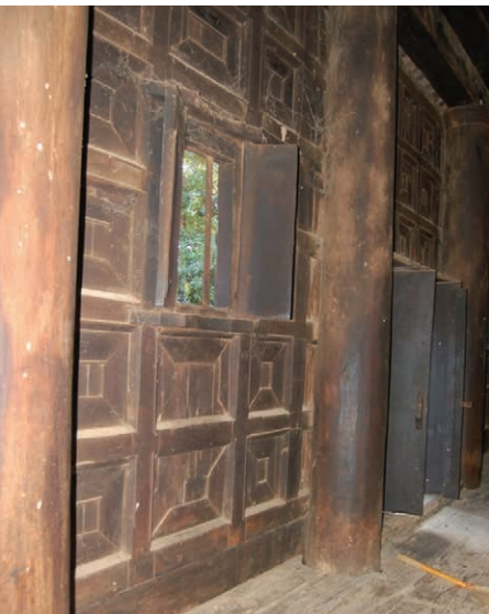
写真 26 外壁の室内面 (同上)
