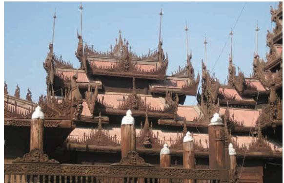
写真39 軒先を彫刻で飾られた屋根（シュエインビン僧院）
