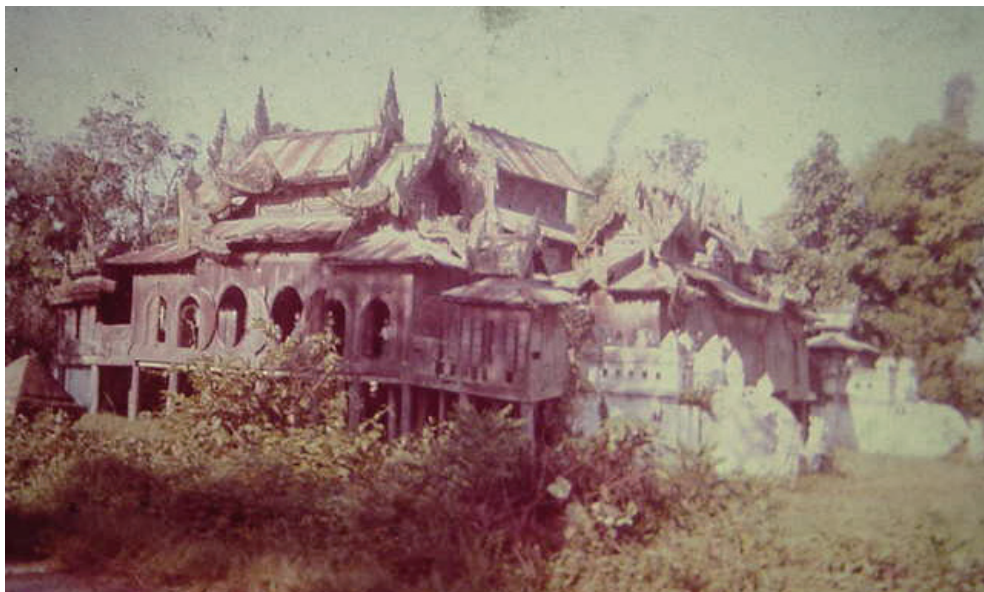
1968年著者撮影。建物は崩壊し、床や柱が傾き、木彫の装飾は失われている。しかし僧侶はまだ生活していた。屋根の軒先飾りはコンバウン朝時代の僧院とは若干異なる。楕円形の開口部は北方の影響である。
