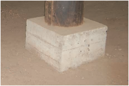
写真 44 柱基部の RC 基礎
