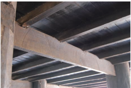
写真 45 床根太と貫材の納まり
