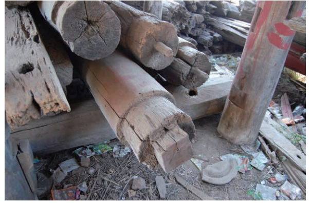
写真 16 柱頂部の角納と丸納（バガン所在の僧院建築の廃材）
