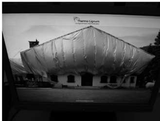
Thermo Lignum 社 による、建物の 温熱処理による 殺虫処理の例
