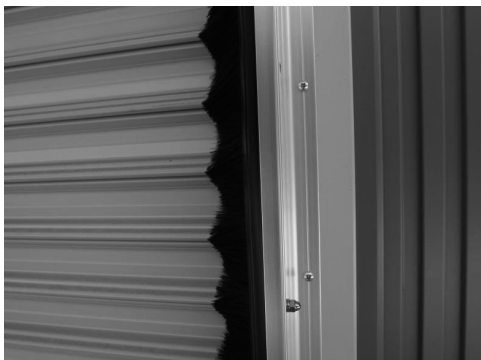
写真5 シャッターブラシの設置
