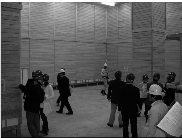
図9 収蔵庫施工の検査
