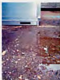
建物周囲の水の溜まり方
