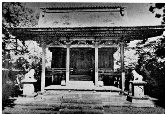
261 熊野奥照神社本殿
