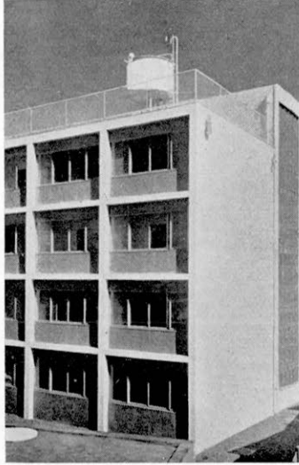
230 関東通信病院看護婦宿舍 日本電信電話公社建築部
