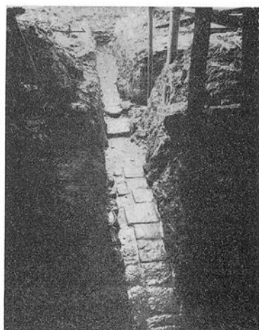
二二 同上工事中發見遺溝の一部
