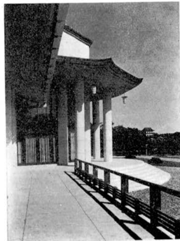
一六 同上 中央ロビー外観
