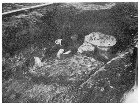
二三 同上工事中發見石白竝に九瓦による排水溝の發掘状態
