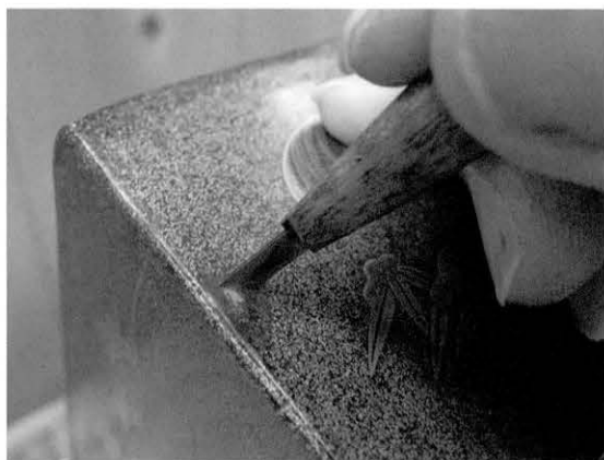
図 21 彫刻刀による後世修復の除去 修復中
