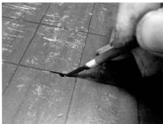
図 22 漆塗膜の剥落止め 修復中
