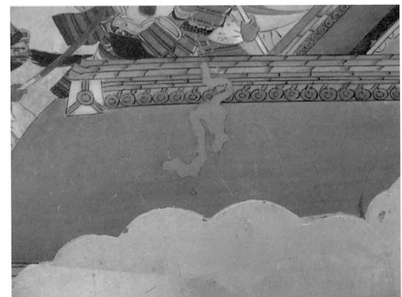
図6 デイテール (修理後) Fig. 6 Detail (After treatment)
