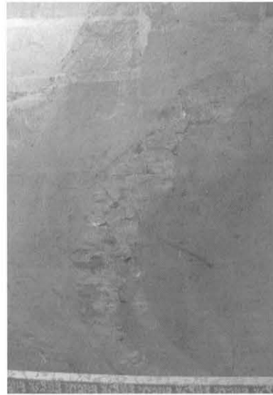
図4 損傷 修理後 左隻 第5扇 ディテール Fig. 4 Damage. After treatment. Detail of left screen, 5th panel.
