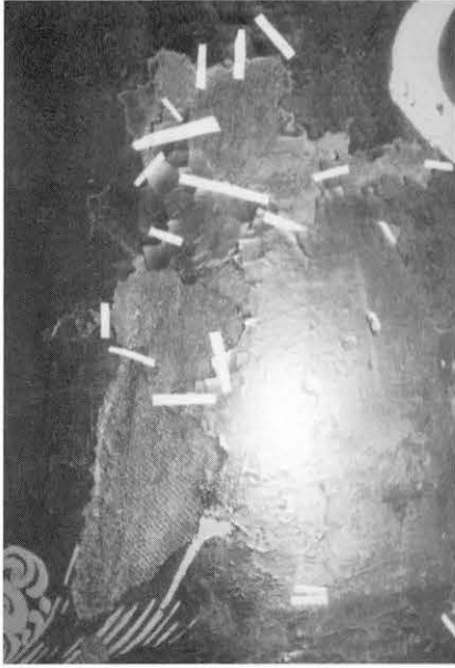
図20 漆塗膜の剥落危険箇所を雁皮により養生
