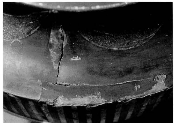
88 充填材の下から現れた亀裂 Crack found under the filling material
