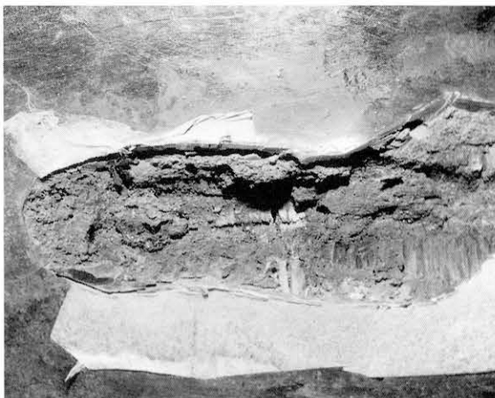
図70 屋蓋の素地割目に打たれていた鉋は錆びて劣化している Iron clamp on the joints of the roof
