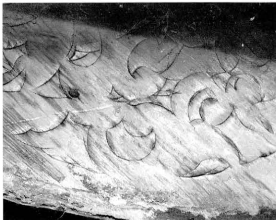
図71 ノミのたたき台として使用された屋蓋 Marks of chiseling on the wooden joint board
