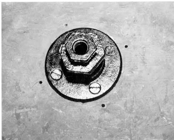
図106 金属ボルトにも漆を塗る Applying raw urushi on the metal bolt
