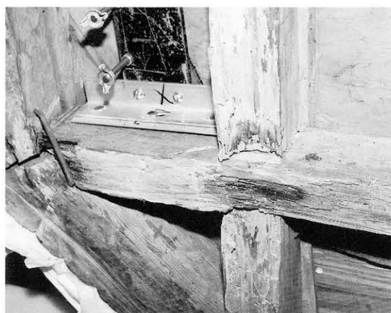
図48 鉄製のアングル Iron angle bar
