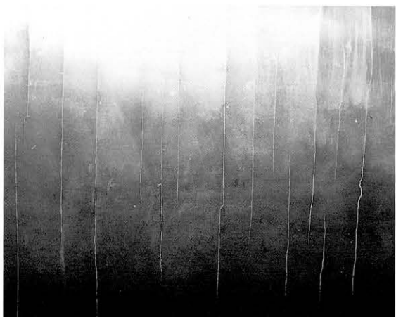
図100 扉の塗膜の亀裂 Cracks on the door
