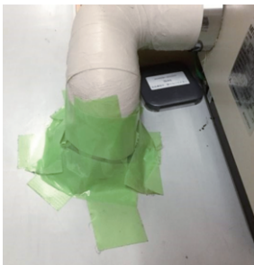
図6 除湿機排水溝のすきま封鎖
