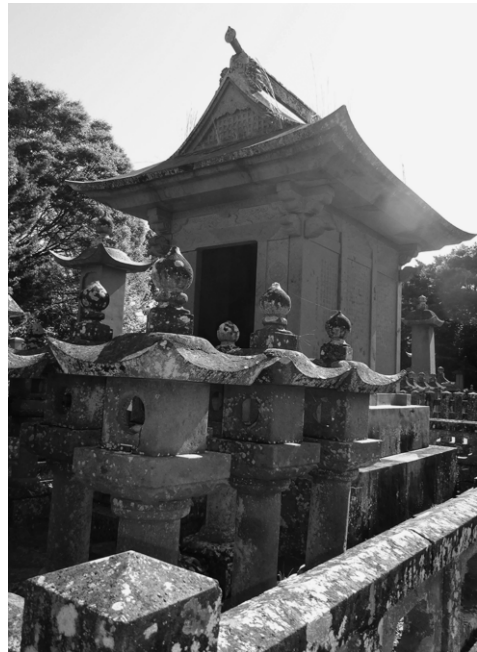
図10 ⑤石霊屋外のセンサー設置状況
