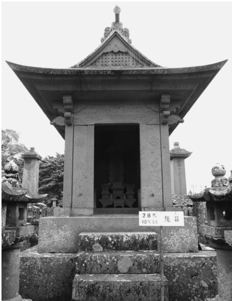
図3 大村純昌石霊屋外観 北西面して入り口が広く開口した状態にある。
