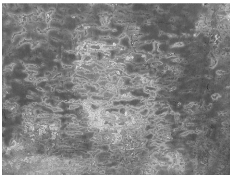
図11 南ティンパヌム黒色付着物と結露の痕跡
