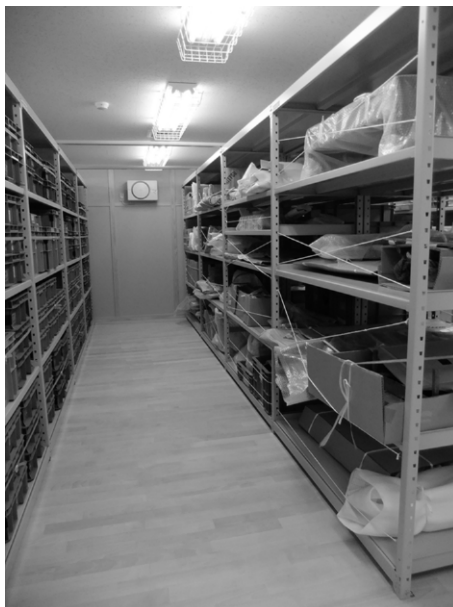
図2 照明の落下防止処置と除湿器の室内機 文化財の落下防止処置は、ひもなど身近な材料で施されている
