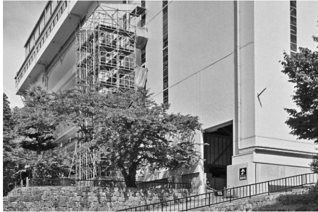
写真8 素屋根外部に設置された作業員監視足場
