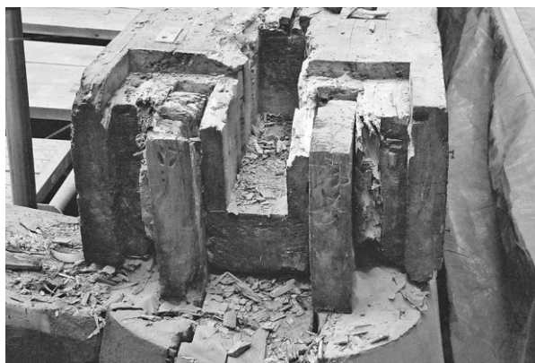
写真2 台輪継手
