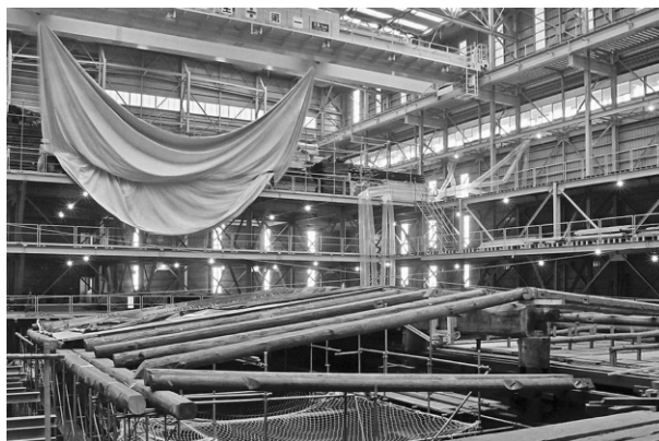
写真10 第1区画建屋被覆作業
