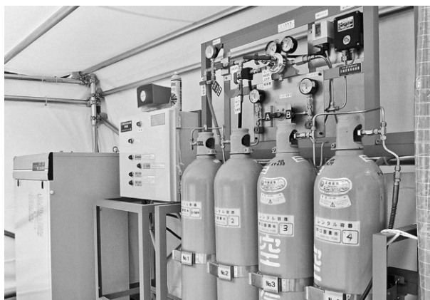
写真5 清浄空気発生機
