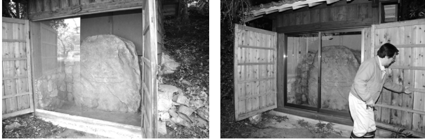
図8 原古墳覆屋内扉の材質変更
