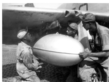
図5 フランジが上下分割タイプのドロップタンク
