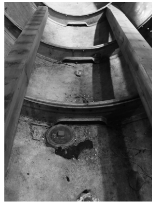
図10 船底弁（元の給油口）
