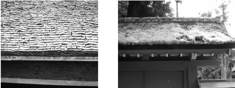
図13 檜皮葺きの例（左）とコケ類が付着した例（右）
