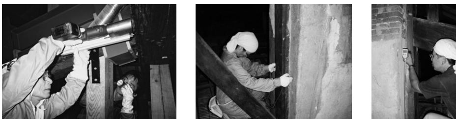
図1 屋根部の調査の状況（2次診断）
