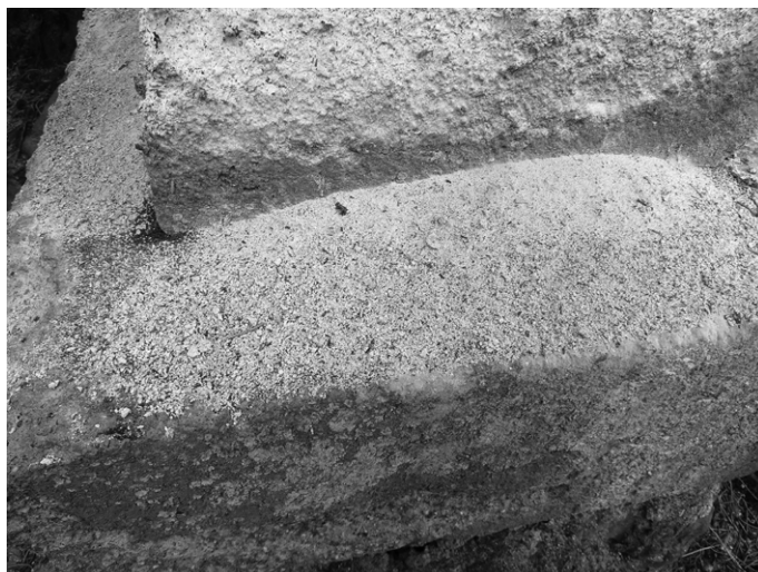
図5. 基礎石上面の崩落物（2012年8月撮影） 石材の崩落片に交じって、白色物質が混在する。
